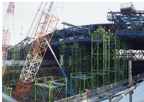
写真一 鉄骨建方状況
