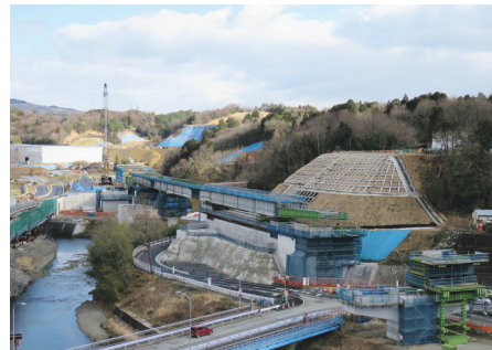
写真二 下り線送出し架設
