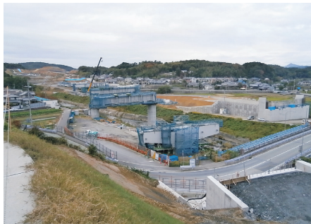
写真一 複合橋脚・箱桁横梁施工状況
