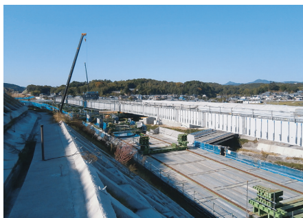
写真三 上り線横取り架設
