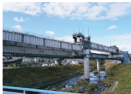
写真四 上り線桁降下
