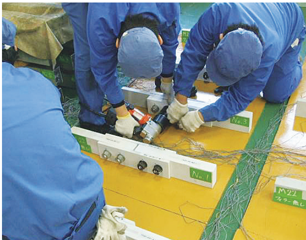
図-5 ボルト締め付けの様子
