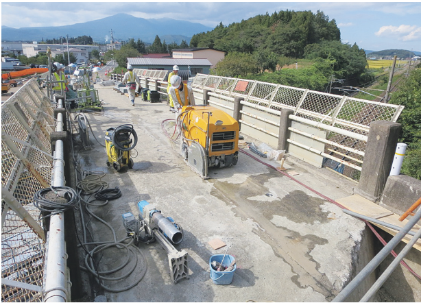
写真-2 A1～P1桁切断状況写真
