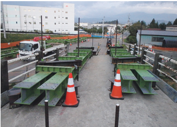
写真-6 吊り梁設置完了写真
