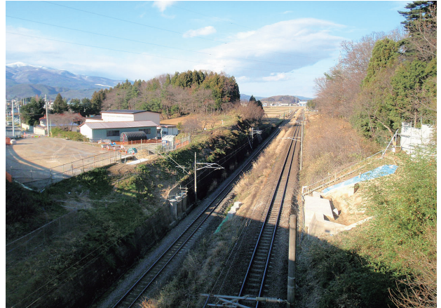
写真一18 撤去完了写真
