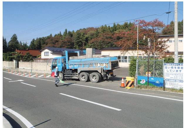
写真一14 撤去桁搬出状況写真
