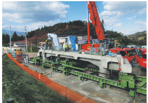
写真一13 撤去桁切断状況写真
