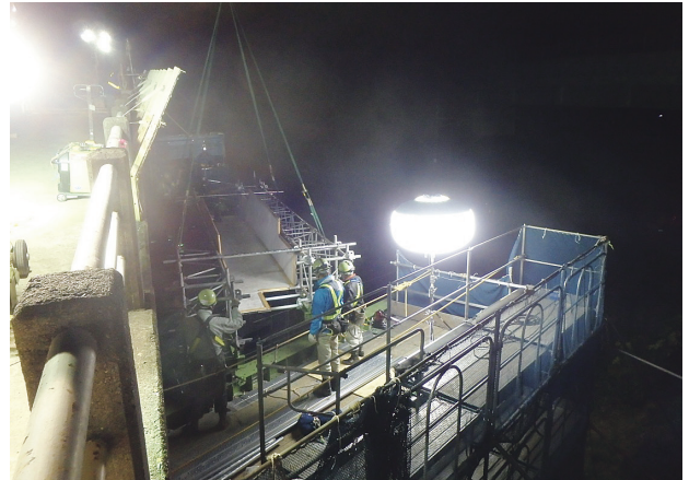
写真-3 P1～P2間防護工架設状況写真
