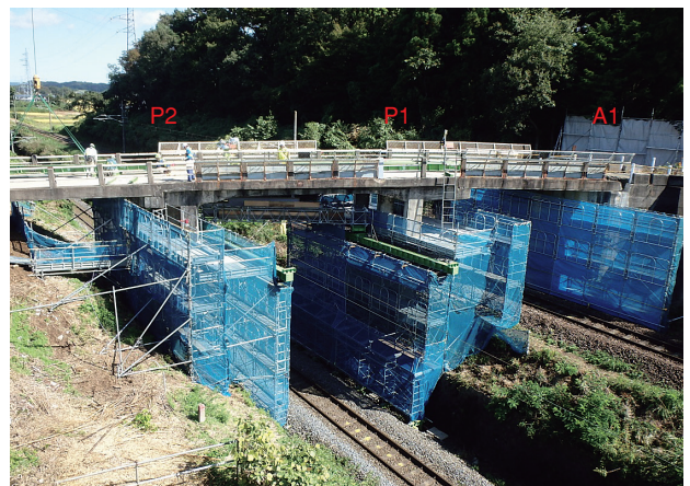
写真-5 足場防護工全景写真
