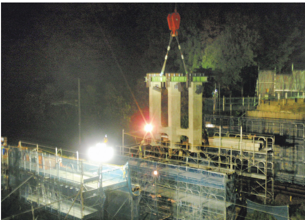
写真一16 橋脚撤去状況写真①
