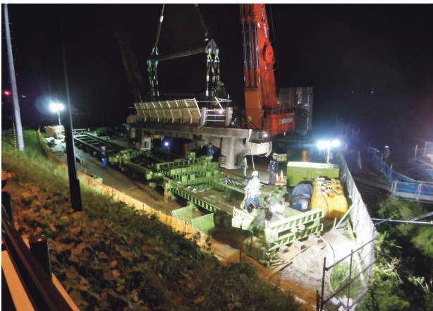
写真一11 P1～P2間桁撤去状況写真②
