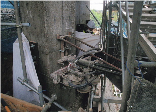
写真一15 橋脚切断状況写真
