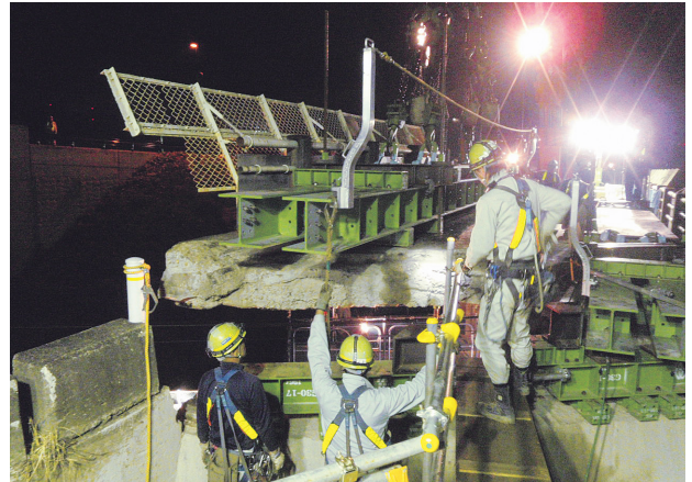
写真-8 A1～P1桁撤去状況写真
