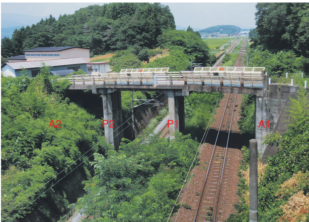
写真-1 橋梁撤去前全景写真
