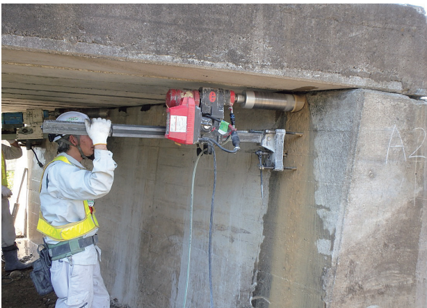
写真-7 アンカーボルト切断状況写真
