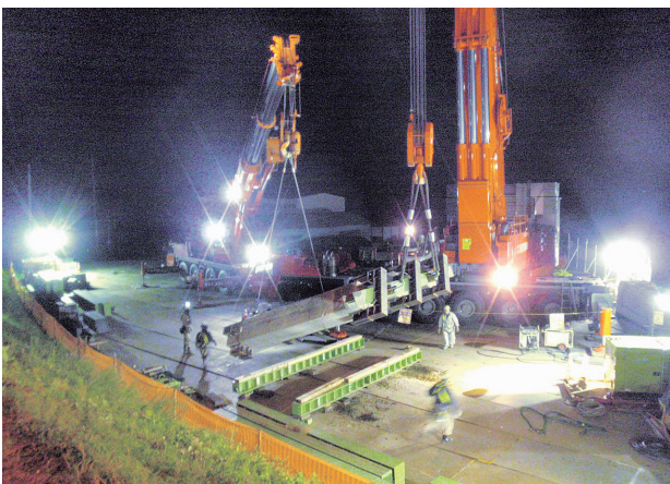
写真一17 橋脚撤去状況写真②
