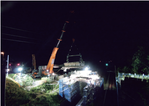
写真一10 P1～P2間桁撤去状況写真①
