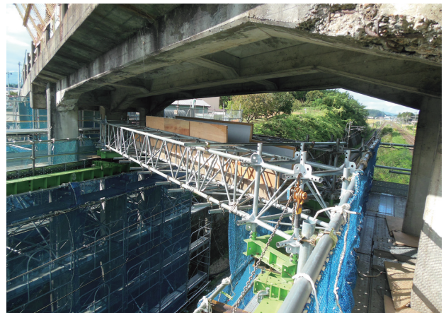
写真-4 P1～P2間防護工設置状況写真
