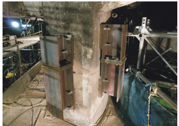
写真-9 橋脚固定金具設置完了写真
