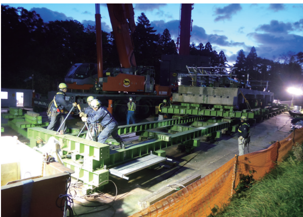
写真一12 桁縦取り状況写真
