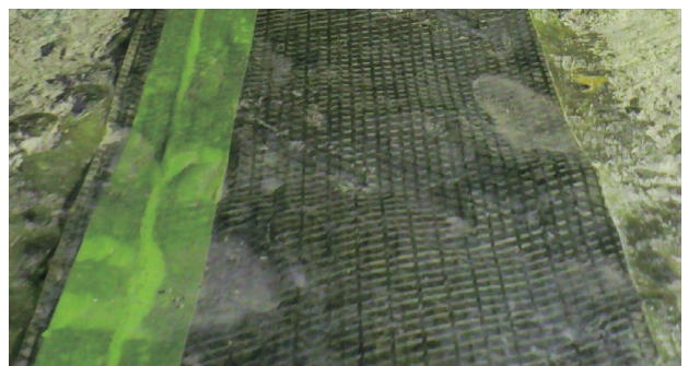
写真-4 タフメッシュシート貼付け状況
