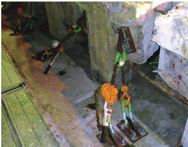
写真-5 仮固定設備
