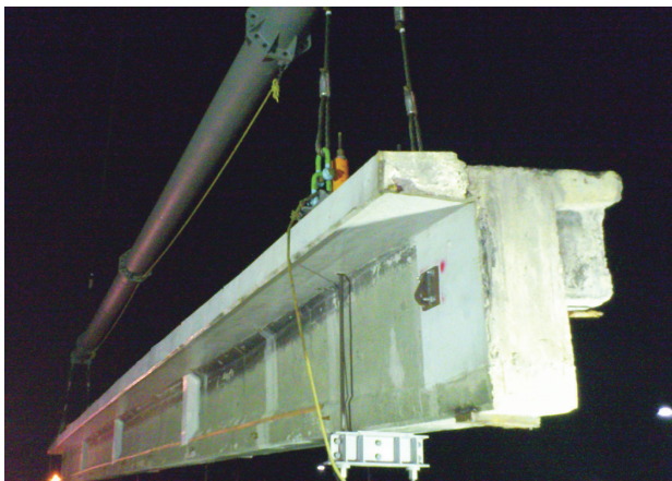
写真-6 吊り天秤
