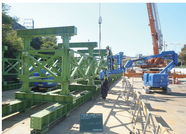
写真-1 切断桁仮受けベント組立
