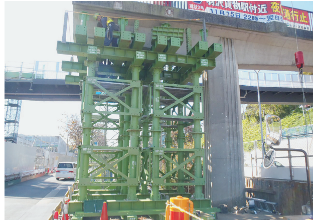
写真-6 桁受けベント組立
