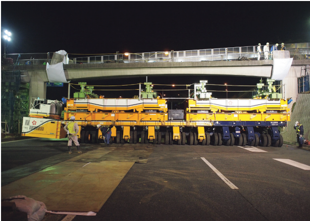
写真-8 ユニットキャリア据付
