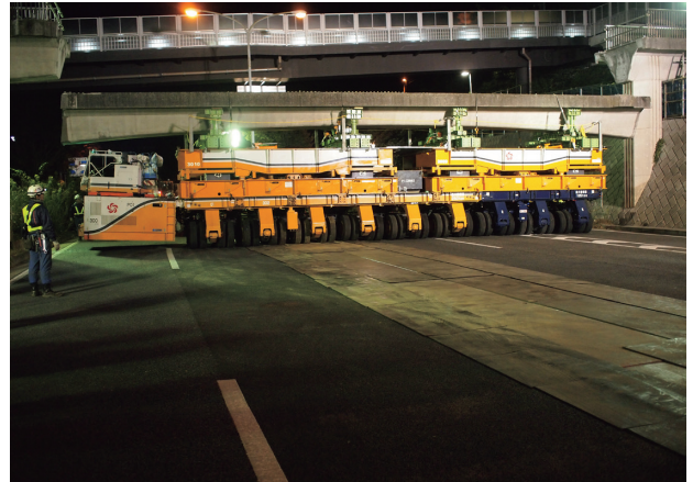
写真-11 デッキリフト降下
