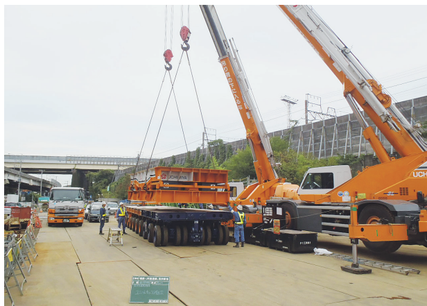
写真-2 デッキリフト組立
