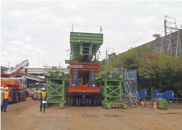
写真-3 デッキリフト上昇試験
