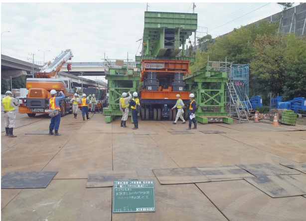
写真-4 デッキリフト下降試験
