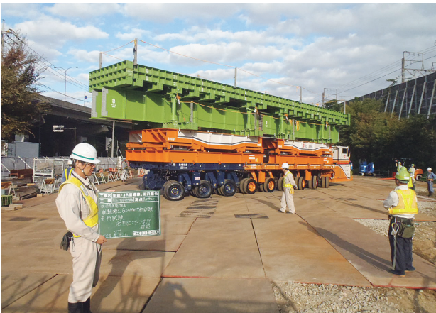
写真-5 ユニットキャリア旋回試験
