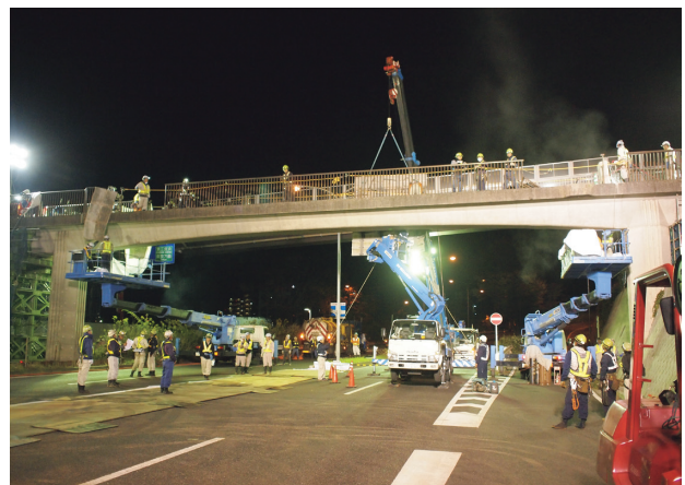
写真-7 ユニットキャリア据付前作業
