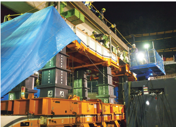
写真-9 デッキリフト上昇、桁受け
