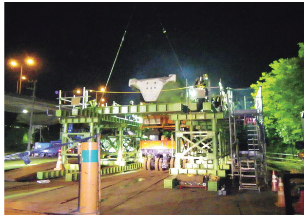
写真-13 撤去桁仮受け
