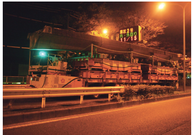
写真-12 撤去桁搬出
