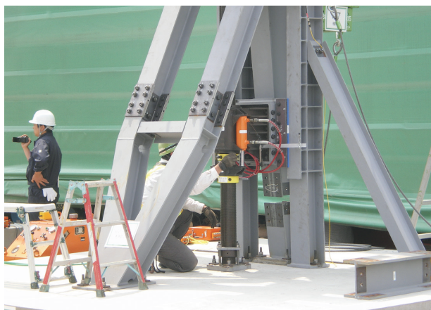
図-12 試験施工時状況写真2
