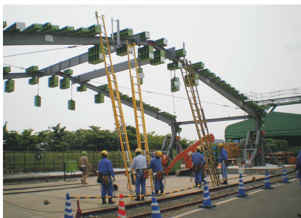
図-11 試験施工時状況写真1
