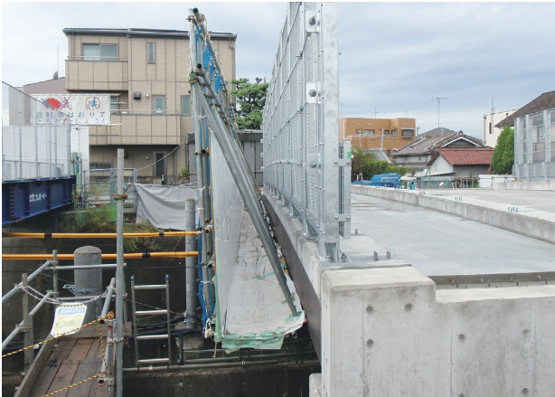
写真-10 新設桁側部足場
