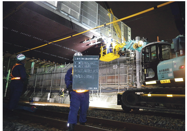
写真-12 軌陸高所作業車による足場解体
