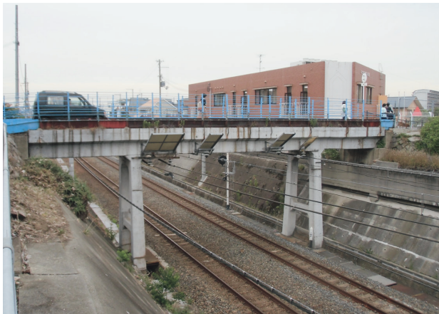
写真一 既設橋全景側面方向（施工前）
