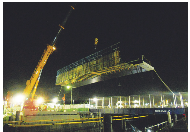
写真一9 新設桁架設状況
