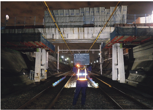
写真一7 既設桁側径間作業構台足場
