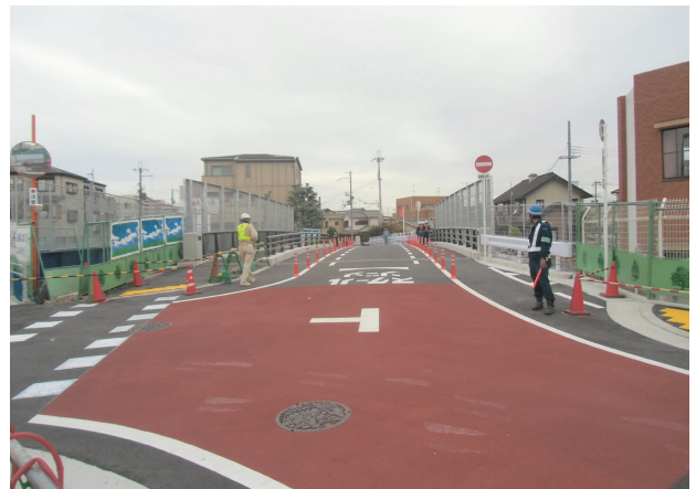
写真四 新設橋全景断面方向（施工完了）
