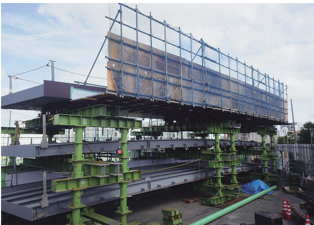
写真-11 3層地組ベント
