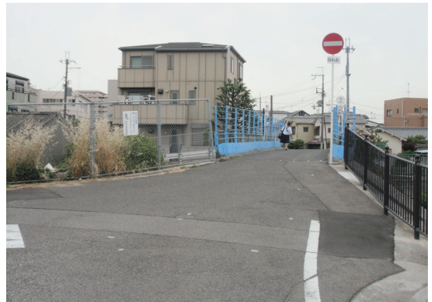
写真二 既設橋全景断面方向（施工前）
