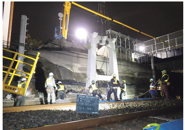
写真-6 既設橋脚撤去状況
