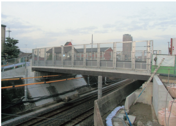
写真三 新設橋全景断面方向（施工完了）
