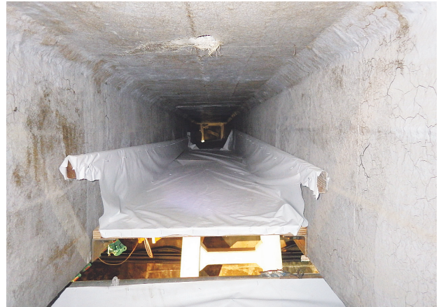
写真一8 既設桁中央径間作業足場
