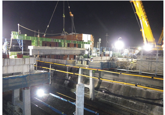
写真-5 既設橋中央径間撤去状況
