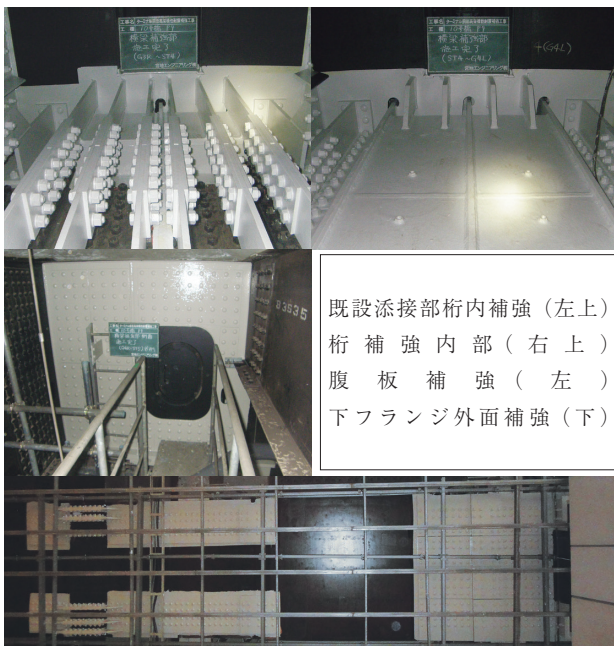
写真-4 桁内部+外部桁及び梁補強
