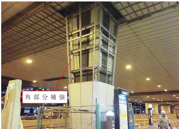
写真-3 補強完了写真 (P1~P12各2脚 合計24本)
