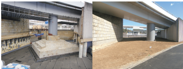
写真-13 フーチング補強
