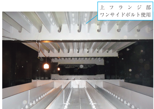
写真-10 ボックス内リブ補強
