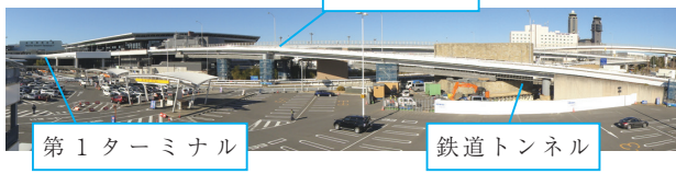
写真-8 Fランプ橋
