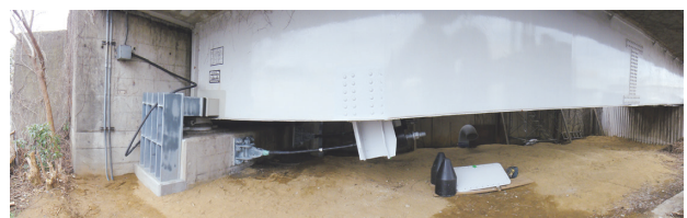
写真-11 変位制限と落橋防止装置
