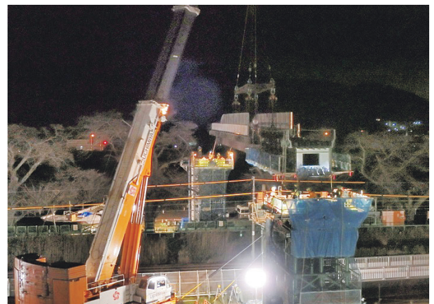
写真-3 東北本線上桁架設状況
