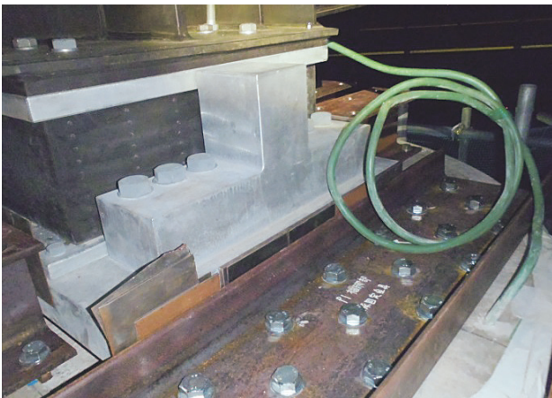
写真-2 支承部耐震設備
