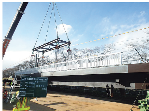
写真一1 地組桁
