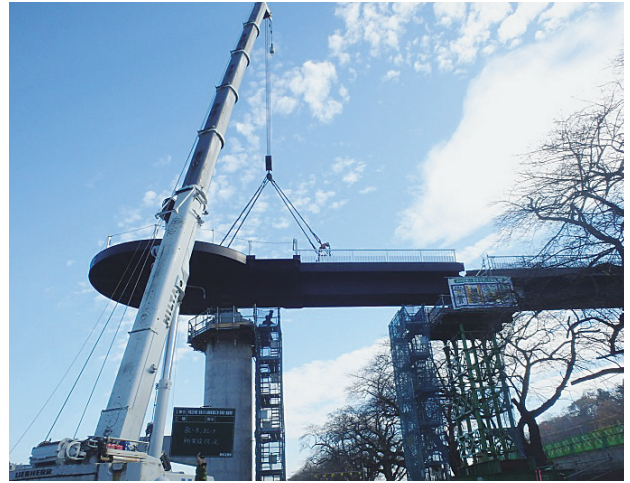
写真-5 河川部桁架設状況
