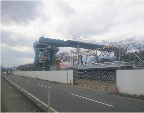
写真-4 東北本線上桁架設完了状況
