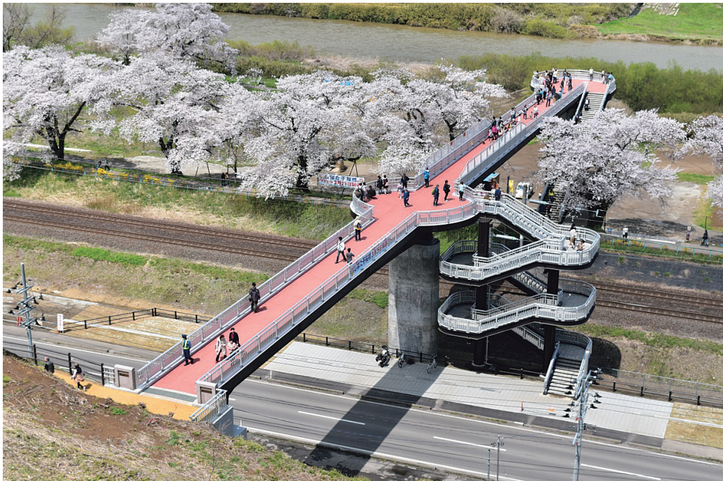
写真-6 完成写真
