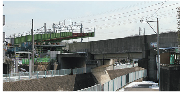
写真-2 上り線桁第1回送り出し状況
