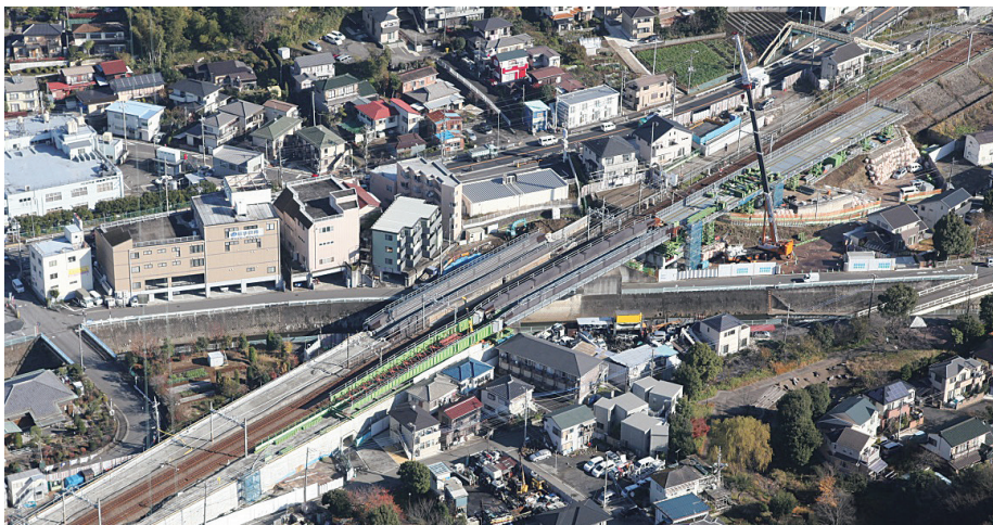
写真一〇 下り線桁架設状況
