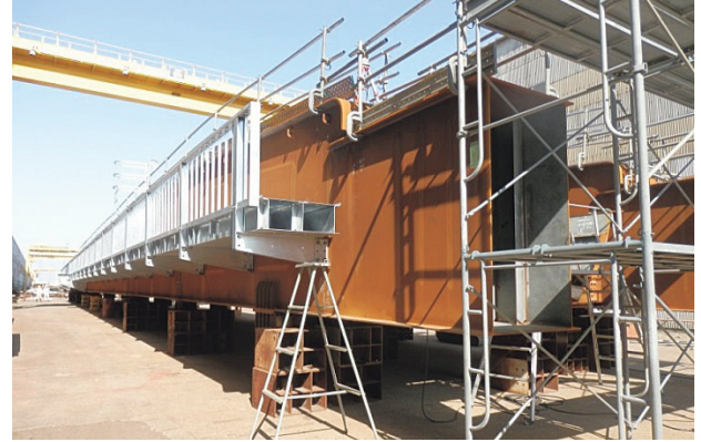
写真-1 千葉工場仮組状況
