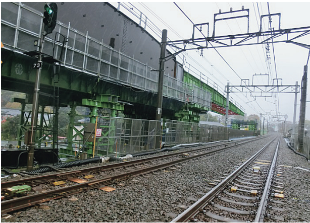
写真一八 下り線桁送り出し状況
