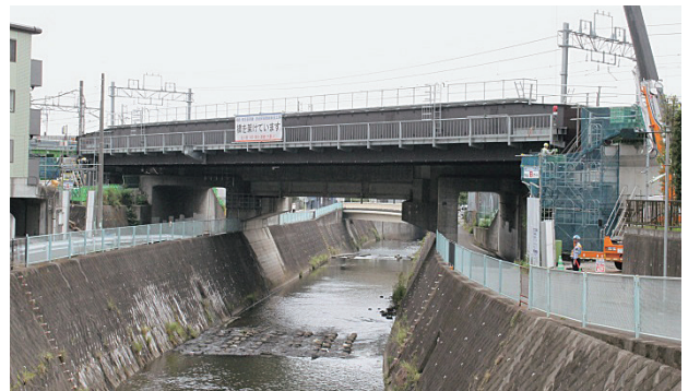
写真-6 上り線桁架設完了
