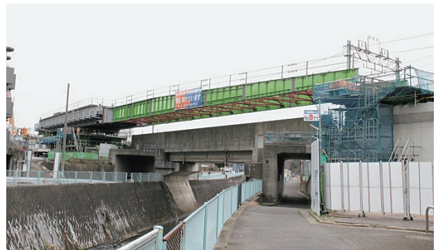
写真-4 上り線桁第7回送り出し状況
