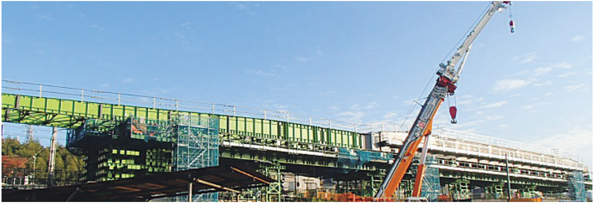
写真一七 下り線桁・手延機組立状況
