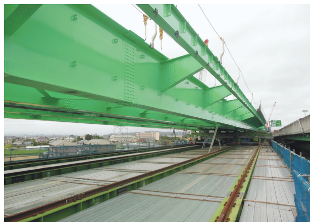
写真-6 P80～P81の鋸桁部
