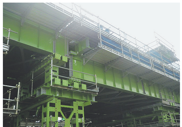
写真-3 軌条設備写真
