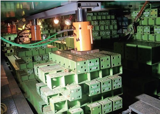
写真-14 桁降下状況
