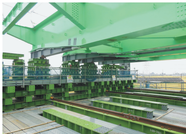
写真-7 鋸桁先端
