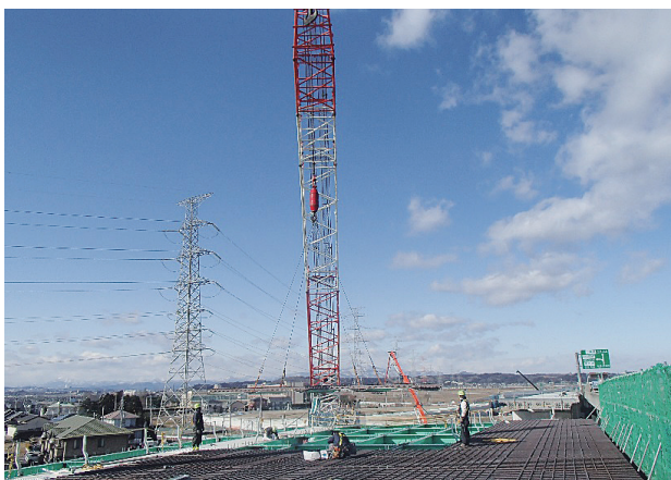
写真-5 グレーチング床版架設状況
