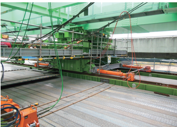
写真-9 水平ジャッキによる送出し
