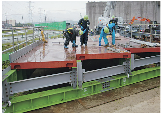
写真-2 水路上栈橋
