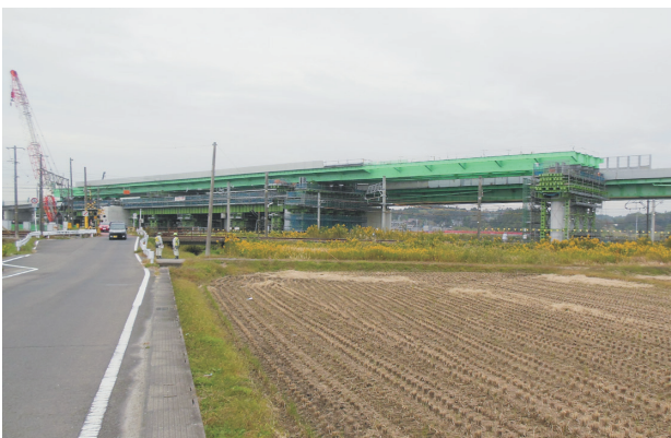
写真-1 全景写真
