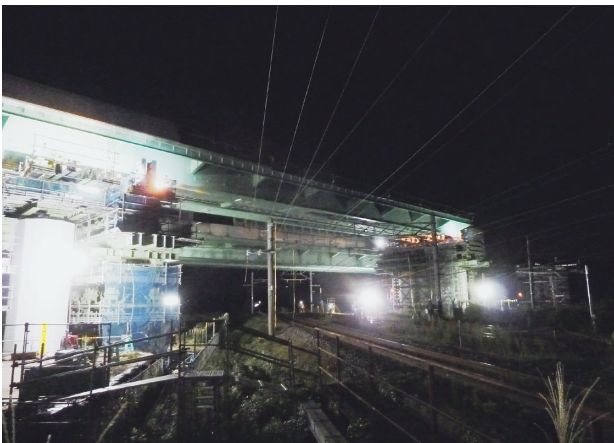
写真-8 JR東北本線上送り出し状況
