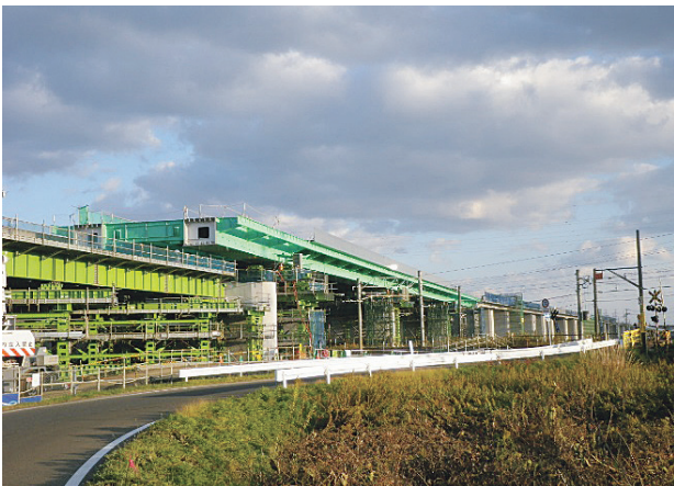
写真-15 桁降下完了
