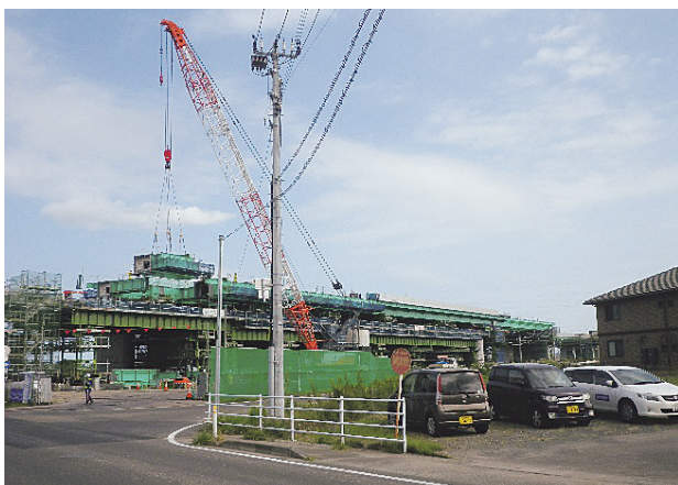
写真-4 桁組立状況
