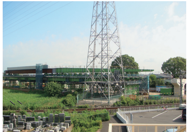
写真-4 手延べ機組立完了
