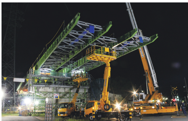
写真-9 手延べ機解体状況
