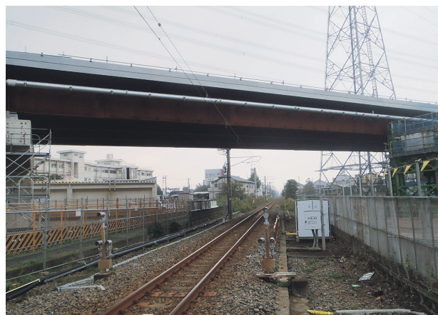
写真-11 架設完了
