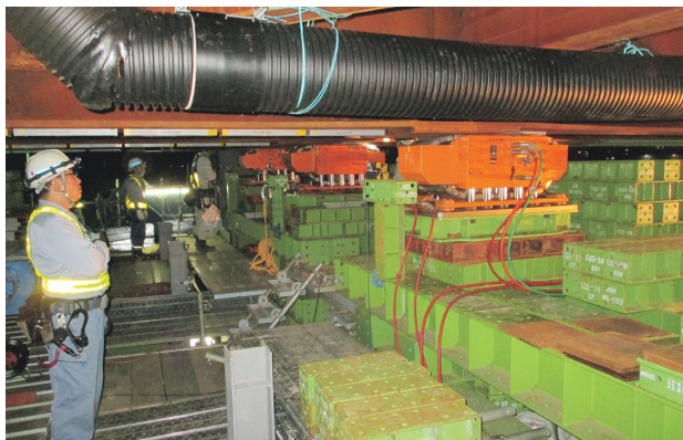
写真-8 シンクロジャッキ
