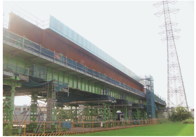
写真-3 桁組立完了
