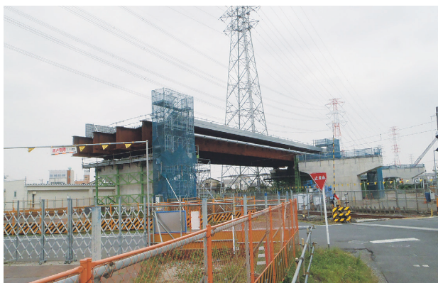
写真-10 送り出し完了
