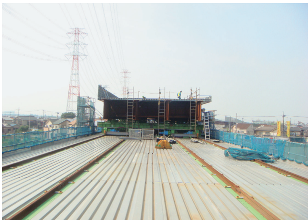
写真-2 軌条設備デッキプレート
