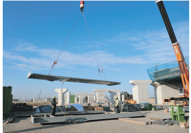
写真一八 合成床版架設状況
