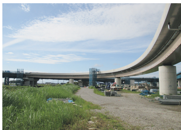
図-12 Dランプ橋完成写真
