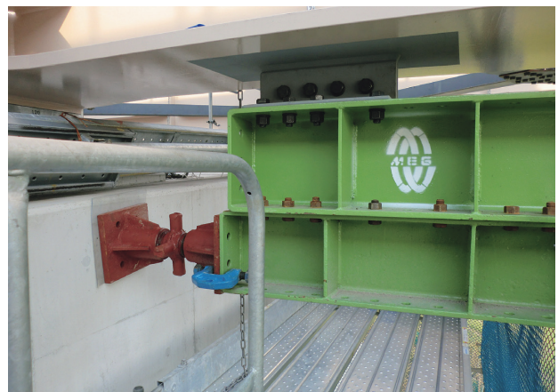
写真-4 支承仮固定設備
