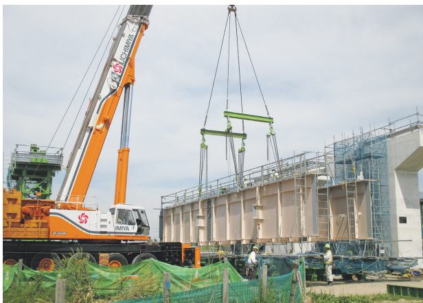
写真-3 5号橋架設状況
