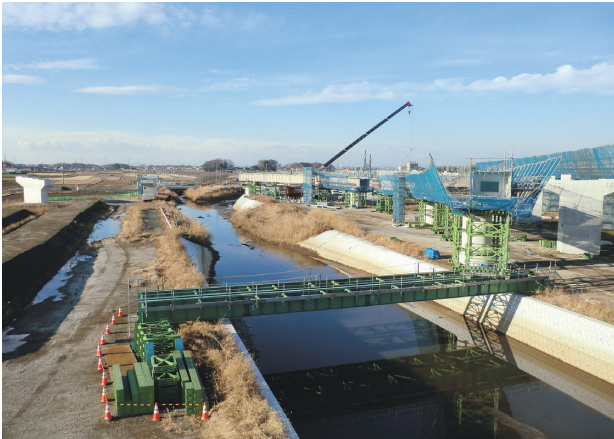
写真一六 工事桁基礎
