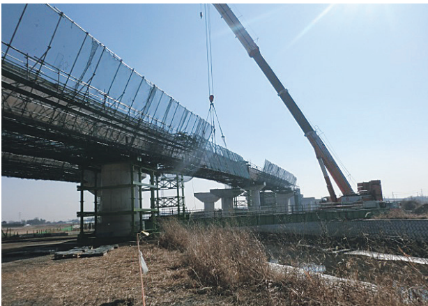
写真一七 Dランプ橋架設状況
