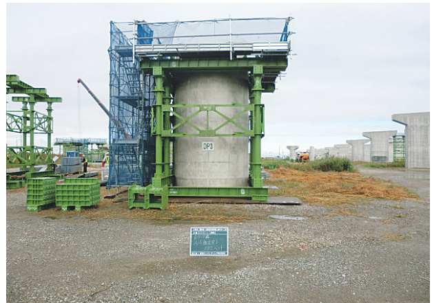
写真-5 脚回りベント設備
