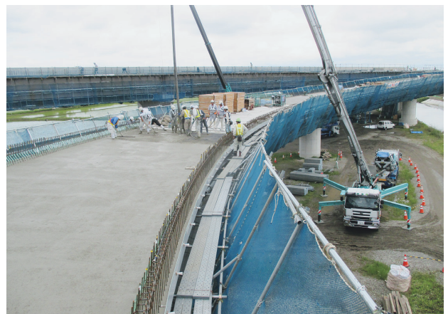
写真一九 床版打設状況
