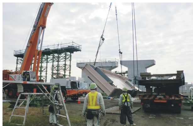
写真-1 主桁建て起こし状況
