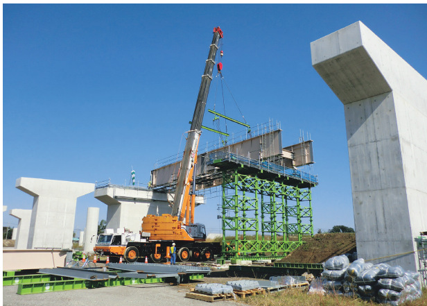
写真-2 7号橋架設状況
