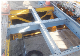
写真-19 横桁、縦桁取替え
