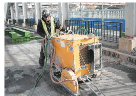
①床板切断
