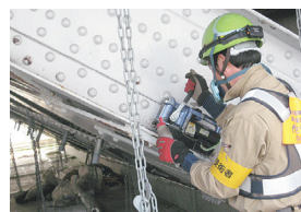
写真-34 リベット撤去状況
