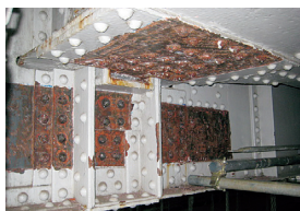
写真-30 変位制限装置接触面
