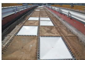
写真-5 バックルプレート取替 写真-6 内面塗装終了後
