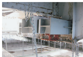
写真-31 変位制限装置設置
