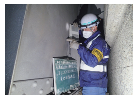
写真-47 素地調整見本帳確認
