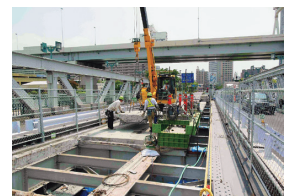
④床板ブロック撤去
