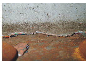
写真-40 プリベントCR塗布後
