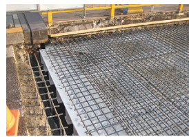
写真-7 新設床版の配筋 写真-8 床版コンクリート打設完了
