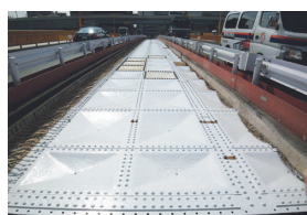
写真-5 バックルプレート取替 写真-6 内面塗装終了後
