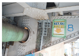
写真-29 あご掛け部補修後
