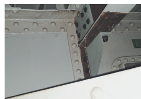
写真-36 中縦桁腹板補強
