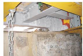
写真-11 排水柵付近腐食状況 写真-12 排水柵付近補修後
