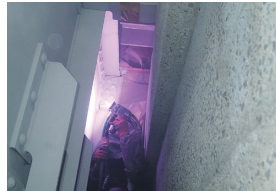
写真-51 溶射状況
