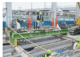
③ジャッキビームによる床板縁切り
