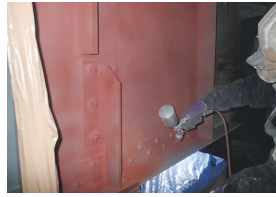
写真-49 粗面化処理確認
