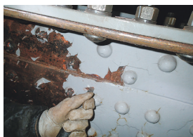
写真-42 中間支点付近
