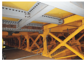
写真-22 横桁、縦桁取替え後
