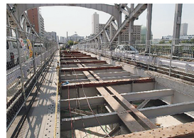
⑤床板撤去完了
