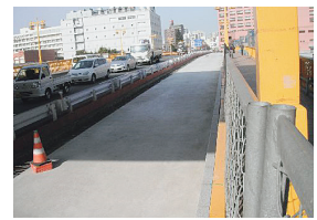
写真-7 新設床版の配筋 写真-8 床版コンクリート打設完了
