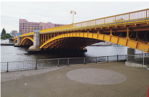
写真-52 左岸（墨田区側）から蔵前橋を望む
