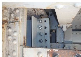
写真-27 ゲルバー部補強
