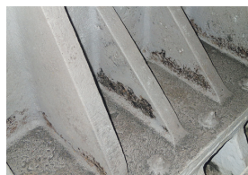
写真-43 中間支点付近
