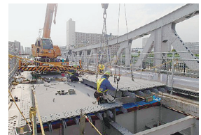
⑥鋼床板架設
