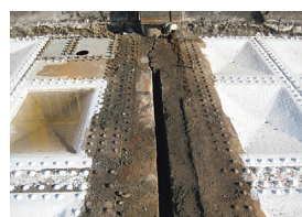
写真-9 桁端部コンクリート撤去前 写真-10 桁端部のコンクリート撤去後
