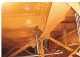
写真-23 主桁取替え前
