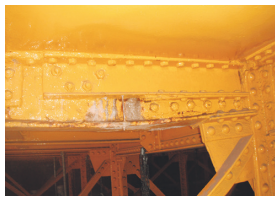
写真-21 横桁取替え前
