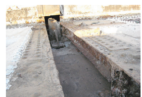
写真-9 桁端部コンクリート撤去前 写真-10 桁端部のコンクリート撤去後
