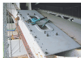
写真-33 下弦材補強後
