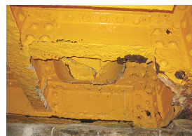
写真-11 排水柵付近腐食状況 写真-12 排水柵付近補修後
