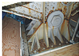
写真-39 中間支点部
