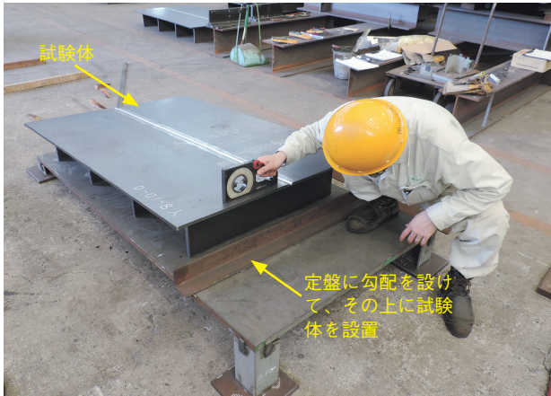
写真-1 試験体設置状況
