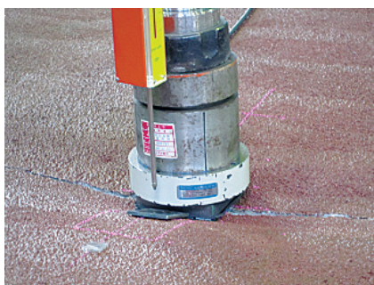
写真-3 リブ間集中荷重載荷試験後の損傷状況
