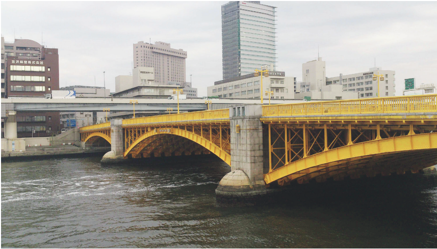
蔵前橋長寿命化工事
