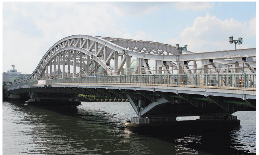
白鬚橋長寿命化工事
