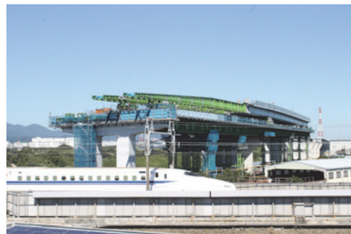
写真-1 下り線桁送出し前
