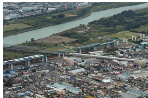
写真-2 第1回桁送出し完了
