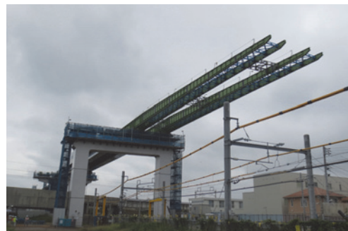
写真-3 下り線桁送出し完了
