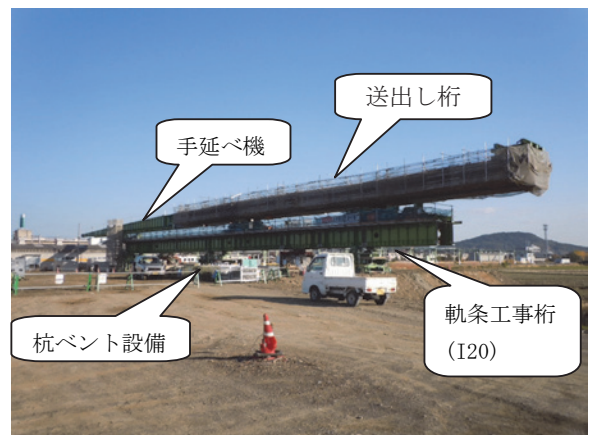
写真－2 軌条工事桁及び杭ベント設備
