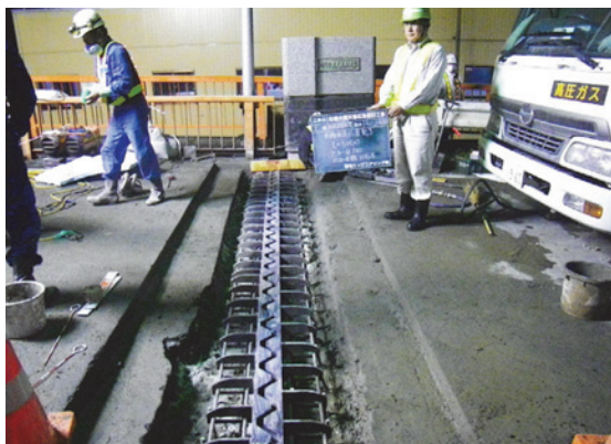
写真-7 伸縮装置設置完了 (P6)
