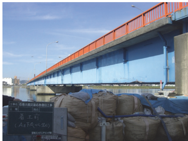
写真一6 石巻大橋全景 (A2側より)
