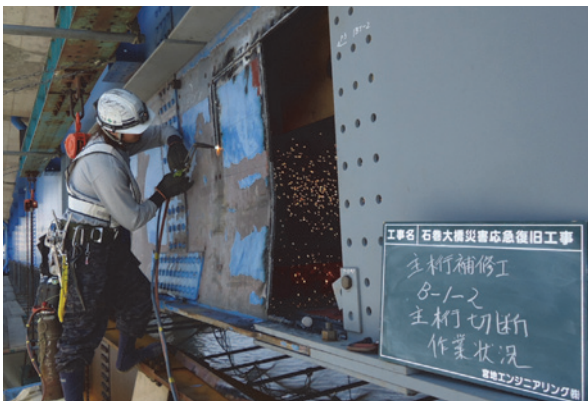
写真-16 主桁ウェブ切断状況
