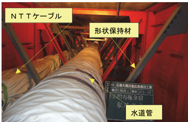
写真-14 形状保持材設置状況
