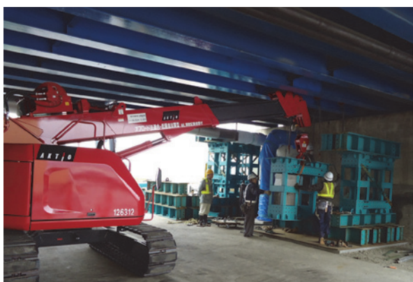
写真-20 ベント組立状況
