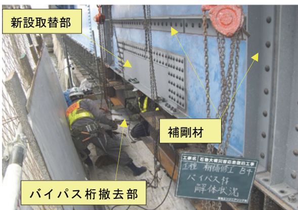
写真-12 バイパス桁撤去状況①
