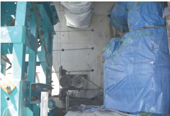
写真-24 ワイヤーソーによる橋脚切断状況
