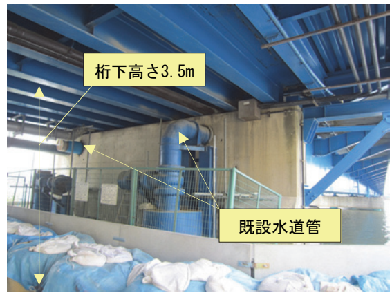
写真-19 P6橋脚 既設水道管埋設状況
