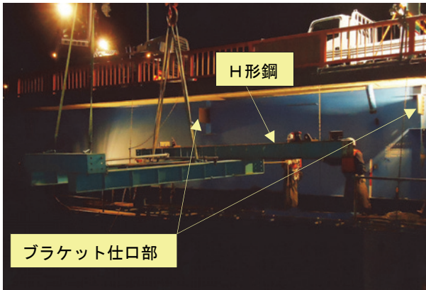
写真-9 ブラケット仕口部へのH形鋼の取付
