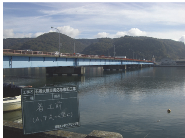
写真一5 石巻大橋全景 (A1側より)
