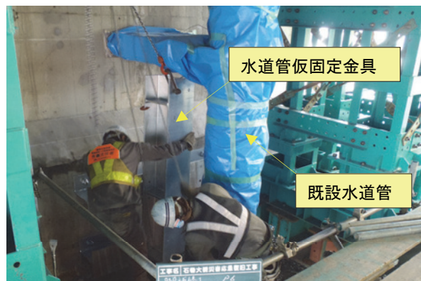
写真-23 水道管 仮固定金具取付状況
