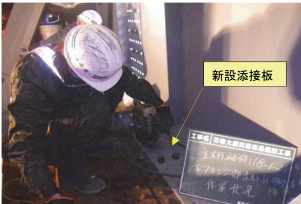
写真-17 新設部材下フランジ現場当てモミ状況
