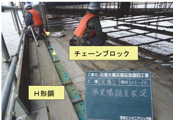
写真-10 H形鋼を利用した吊足場設置状況
