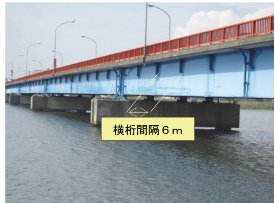
写真-8 主桁上の横桁間隔
