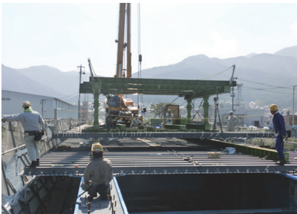
写真一七 台車設備による合成床版パネルの設置
