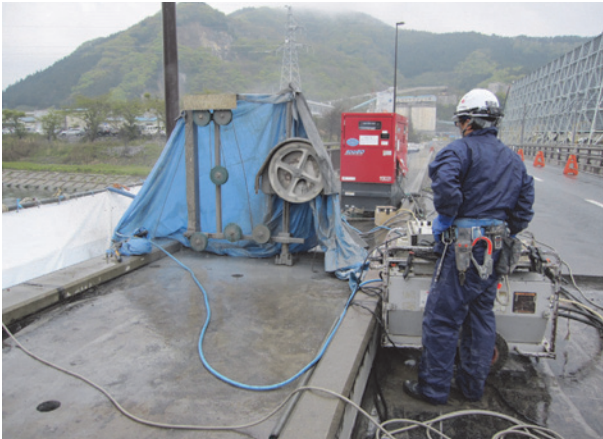
写真-4 ワイヤソーによる合成床版の切断
