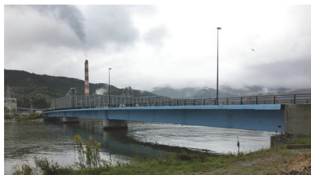
写真一九 災害復旧工事了
