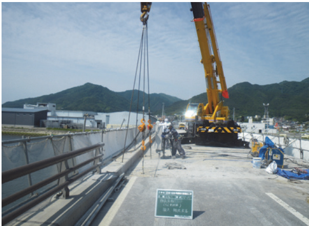
写真-5 合成床版の撤去
