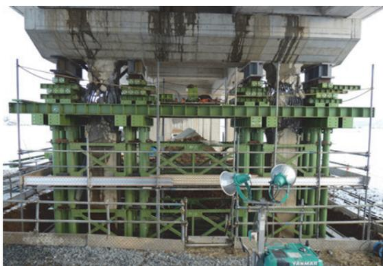
写真-9 支保工設置・仮受状況
