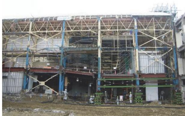
写真-17 陥没部ジャッキアップ完了
