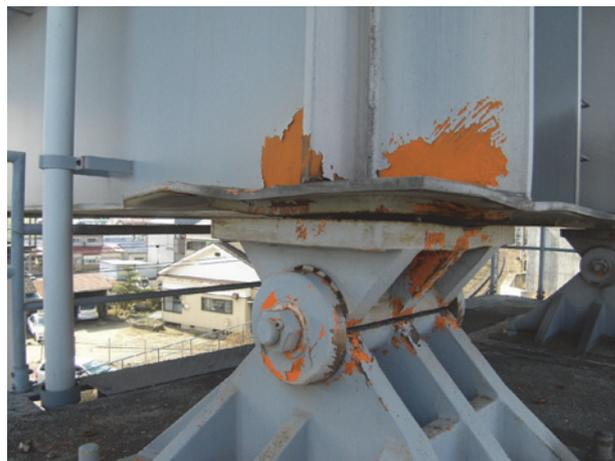
写真-4 貨物線Bi 損傷状況
