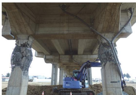
写真-8 RC立体ラーメン高架橋損傷状況
