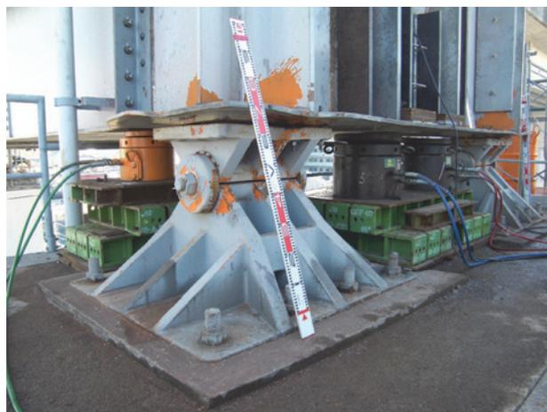
写真-5 ジャッキアップ・仮受設備設置状況
