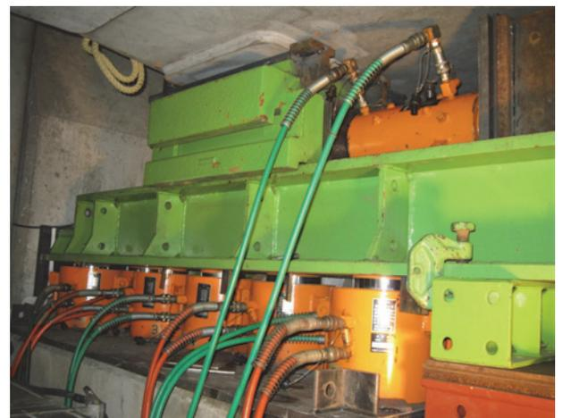
写真-2 横スライド設備設置状況
