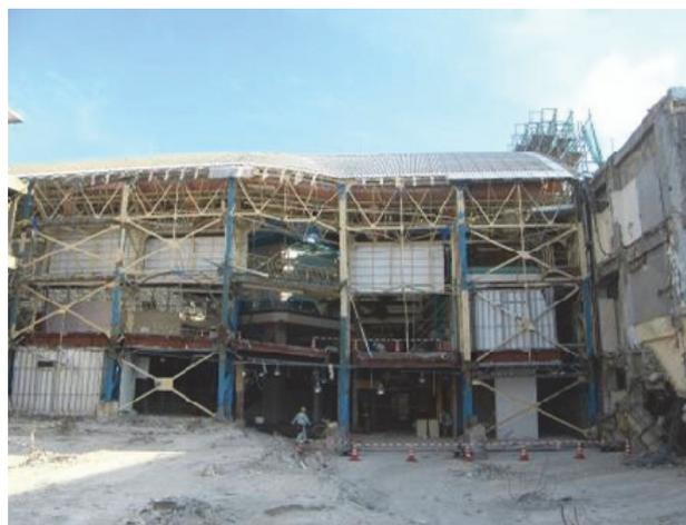
写真-16 陥没部ジャッキアップ前
