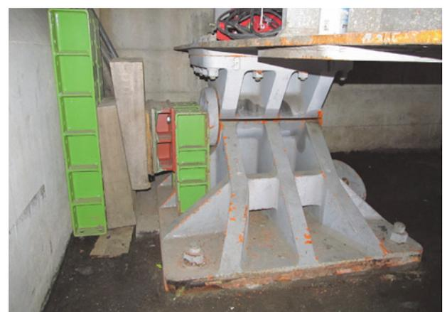
写真-3 応急復旧状況（橋軸直角方向仮固定）
