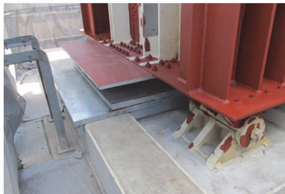
写真-7 恒久復旧状況 変位制限装置設置
