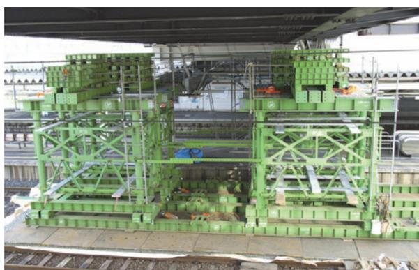
写真-12 旋回・横取り用ベント 設置状況
