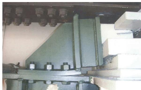
写真-13 大型余震による損傷状況
