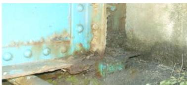
図-2 桁端の損傷事例<sup>1)</sup>
