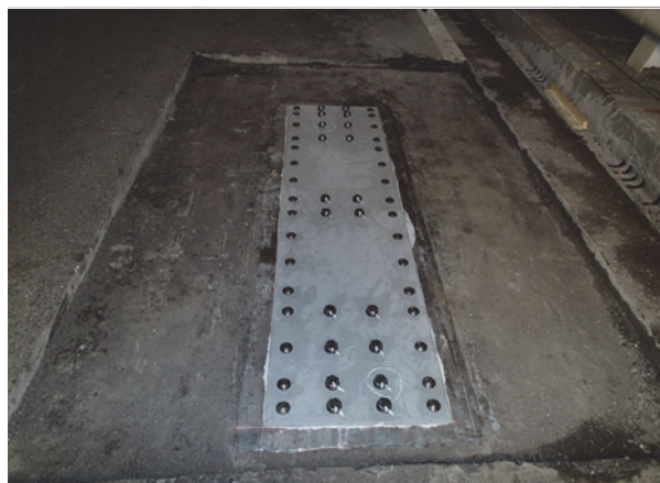
写真-10 本復旧当て板
