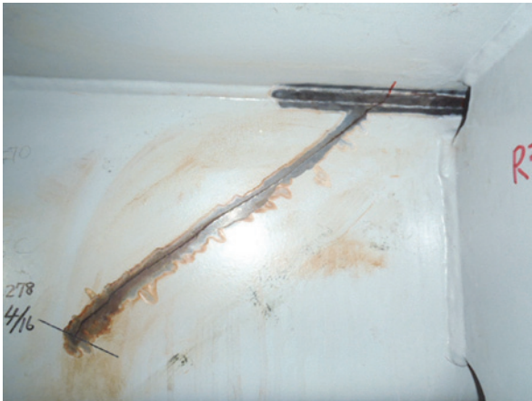
写真-11 ストップホール施工前
