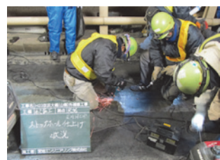
写真-7 ストップホールの施工
