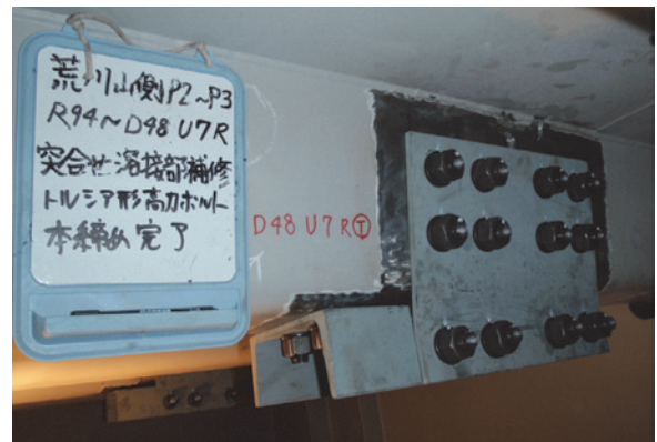
写真-14 Uリブの突合せ溶接部の当て板補修後
