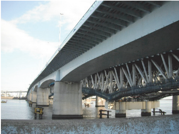
写真-1 荒川河口橋（山側）全景
