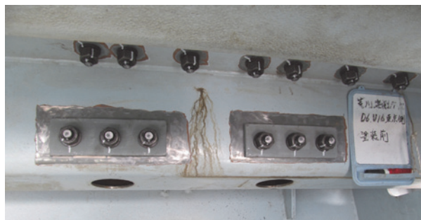
写真-9 ハンドホール設置
