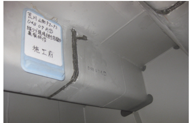
写真-13 Uリブの突合せ溶接部の当て板補修前
