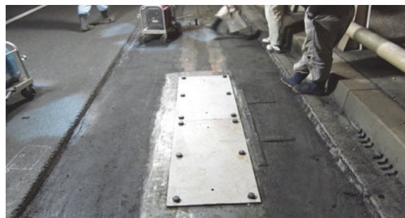
写真-8 仮当て板による補修
