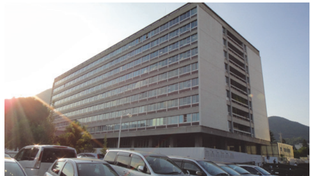
写真-1 建物外観
