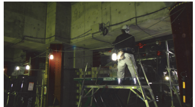
写真-10 切断ブロック取り出し構台
