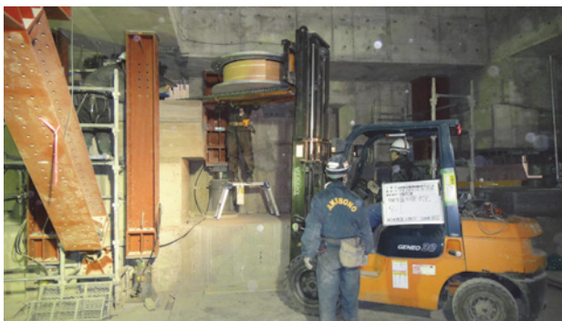
写真-13 免震装置設置
