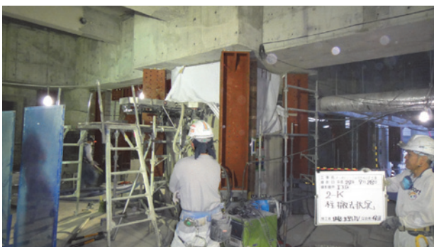
写真-7 柱切断(無水ワイヤーソー)
