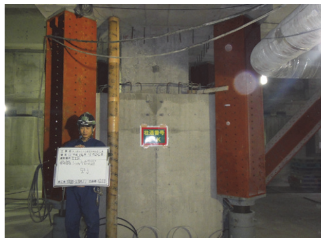
写真-5 仮受け設備 (山留H500)
