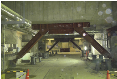
写真-2 鉄骨ブレース
