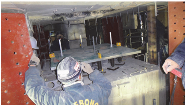
写真-12 下部ベースプレート設置、調整
