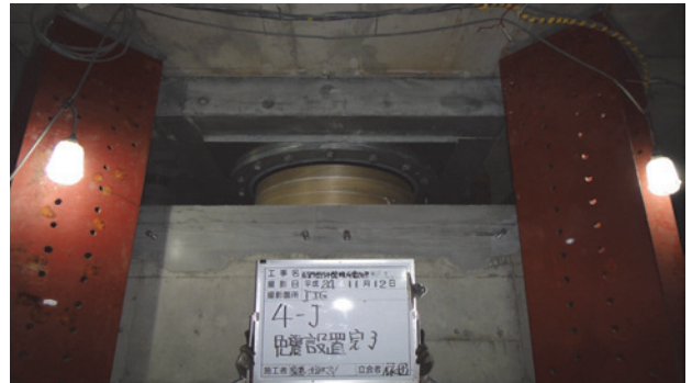
写真-14 免震上下基礎構築完了
