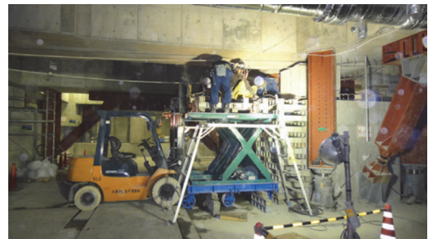
写真-9 切断ブロック引き出し
