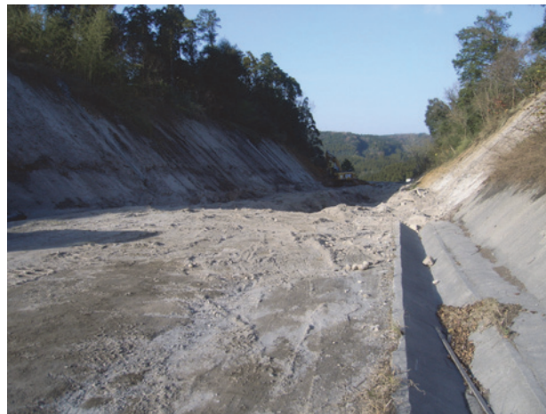
図-5 送出しヤード（造成前）
