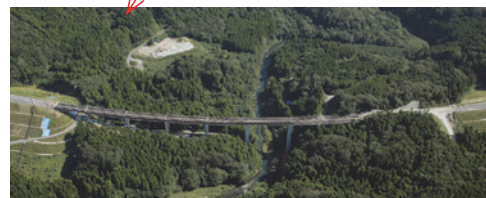
図-2 架設完了後
