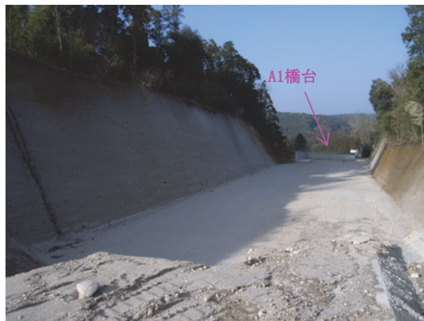
図-7 送出しヤード（造成後）
