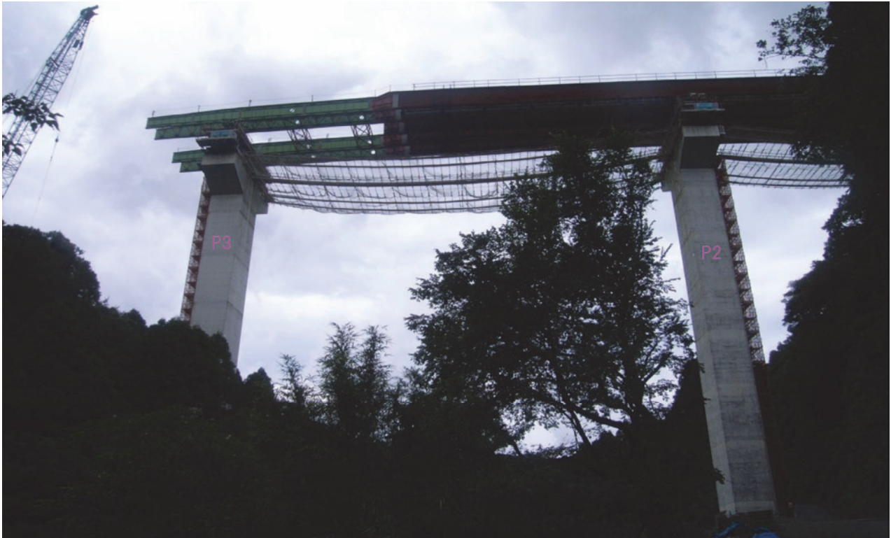
図-12 送出し状況
