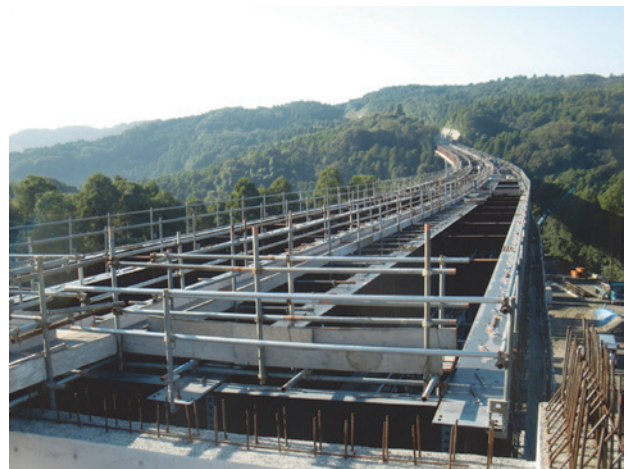
図-16 A2橋台より架設完了後
