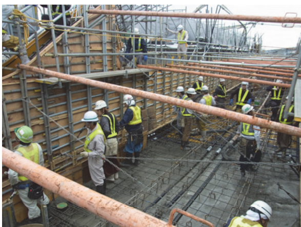
写真-7 補剛桁コンクリート打設状況
