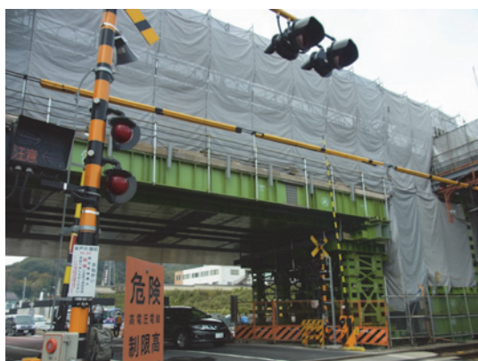
写真-2 道路防護工
