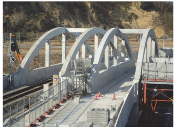
写真-12 横取り・降下完了
