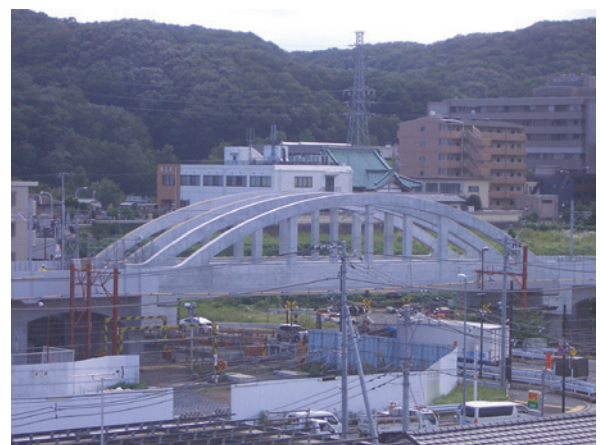
写真-13 完成写真
