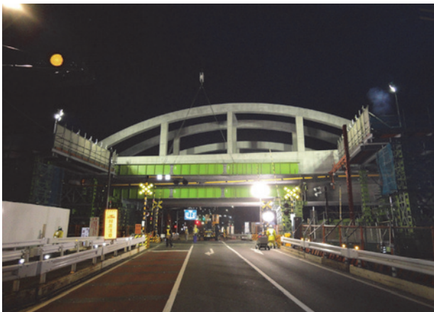
写真-11 道路防護工解体状況
