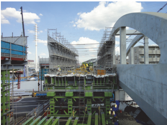
写真-6 仮設備組立状況
