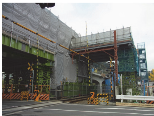
写真-1 線路防護工
