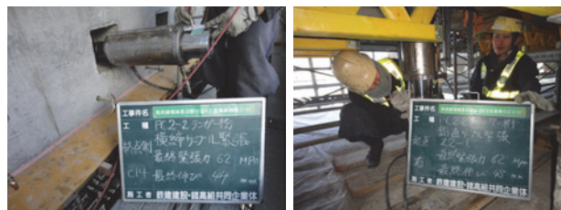
写真-8 横締め・鉛直ケーブル緊張 (SM工法)
