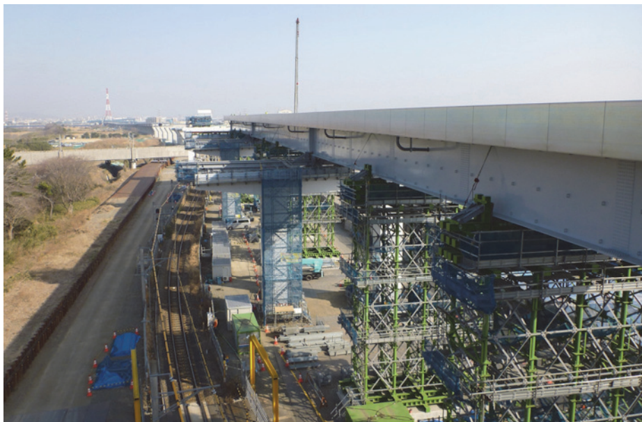
写真一1 横取り前の桁をP93橋脚上から望む
