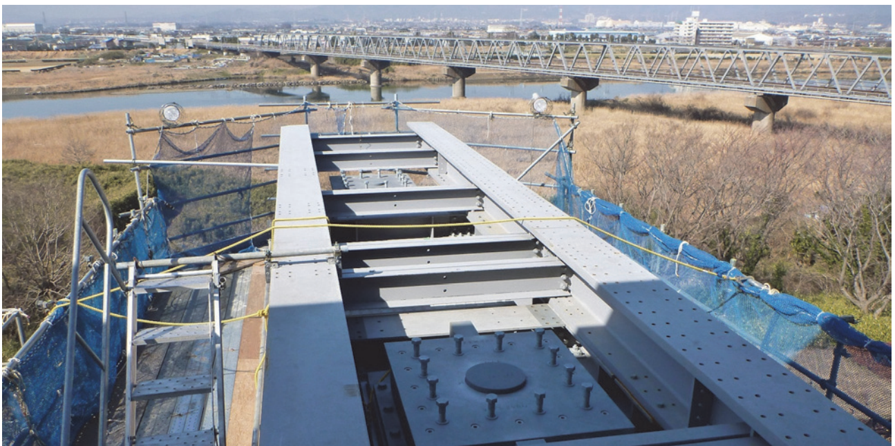
写真-3 軌条梁の配置
