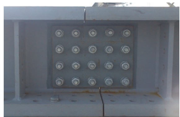
写真-2 軌条梁の継手構造
