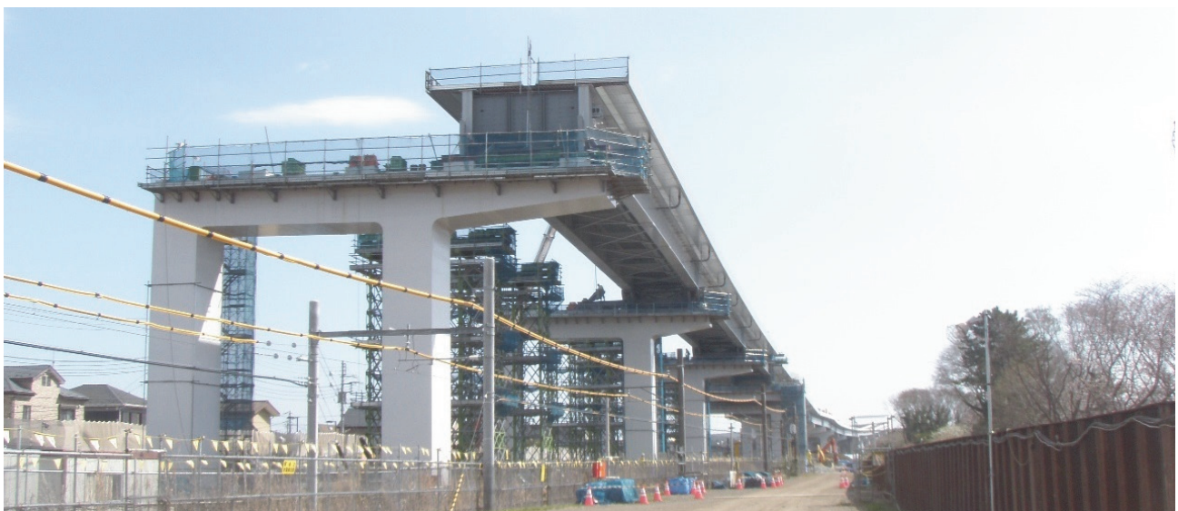
写真-6 横取り後の桁を河川側から望む
