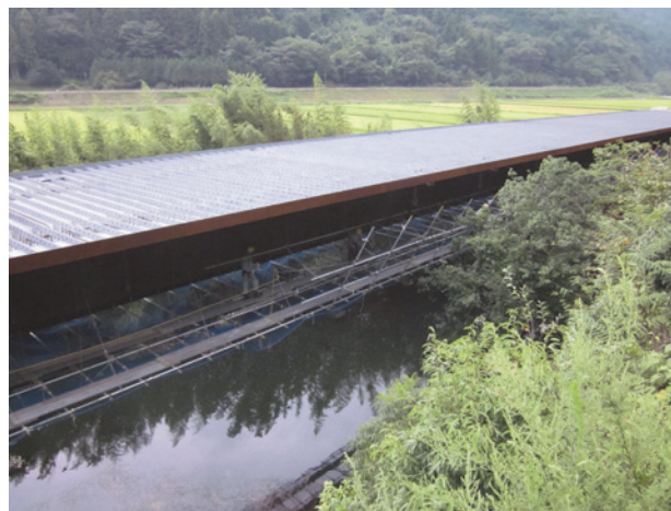
写真-13 合成床版架設完了
