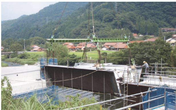
写真-12 主桁クレーン架設
