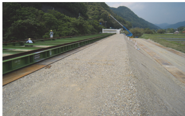
写真-3 送出しヤード
