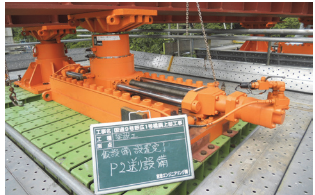
写真-8 スライド式送出し装置
