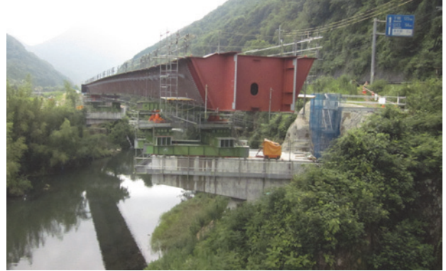
写真-10 主桁降下前
