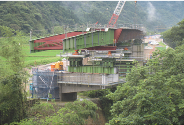
写真-9 送出し架設
