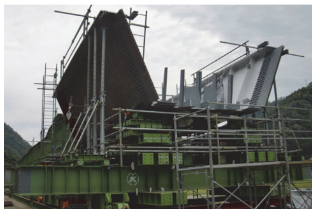
写真-7 送出しヤードでの主桁組立
