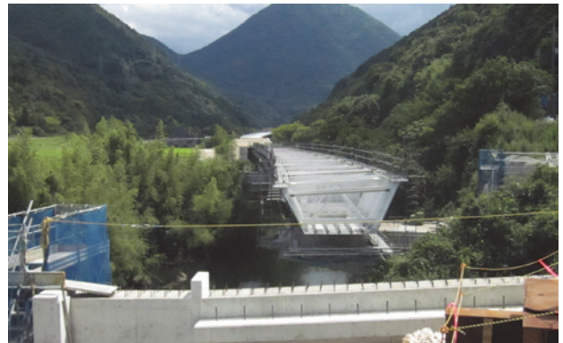
写真-11 主桁降下後
