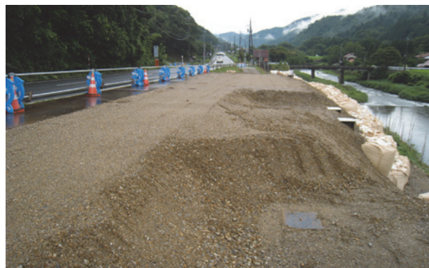
写真-4 A1橋台背面ヤード
