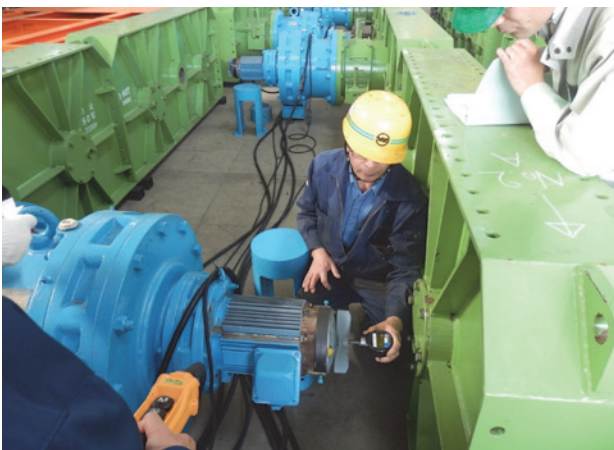
写真-4 モーターの回転数計測状況
