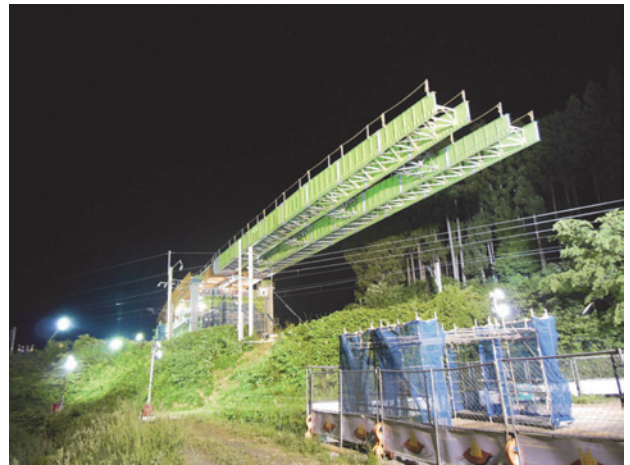
写真-10 送出し状況
