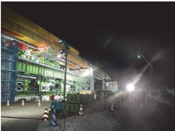
写真-9 送出し状況
