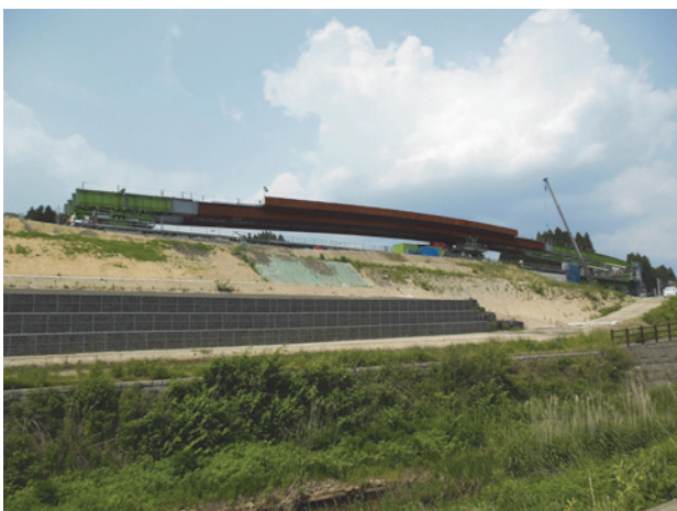
写真-1 送出し桁全景
