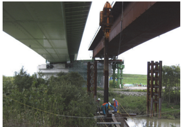
写真-9 杭抜き状況
