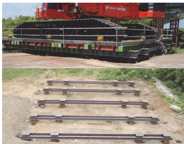
写真-2 クレーン構台
