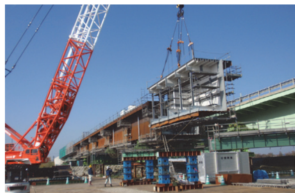
写真-5 2分割架設状況
