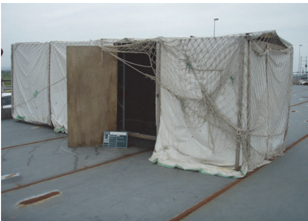
写真-7 溶接風防設備
