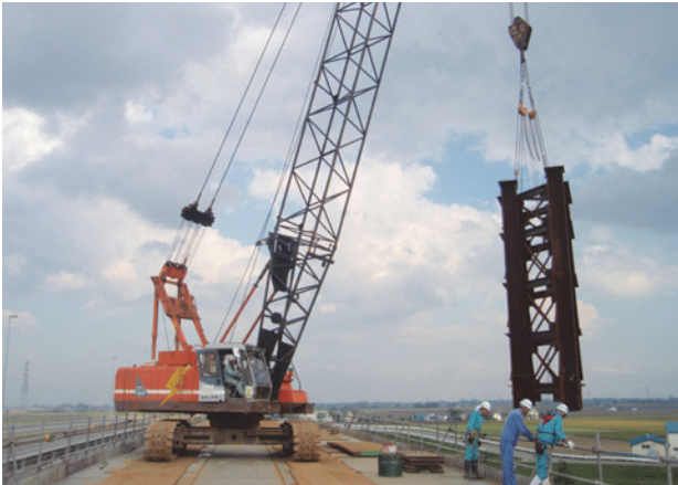
写真-10 杭材撤去状況
