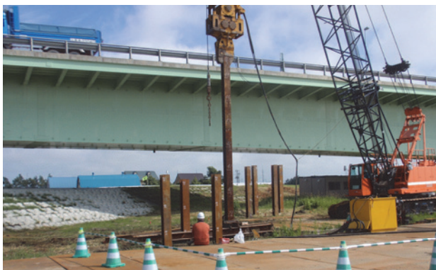
写真-4 ベント杭設置
