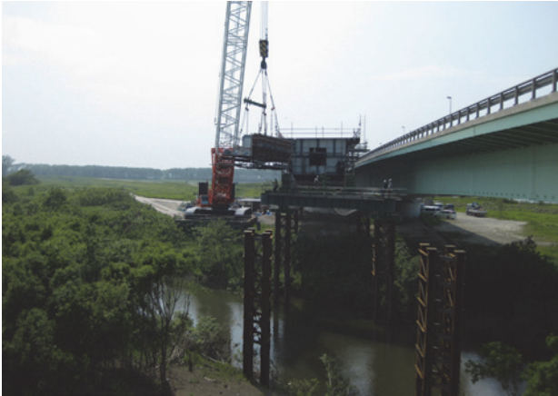
写真-6 4分割架設状況
