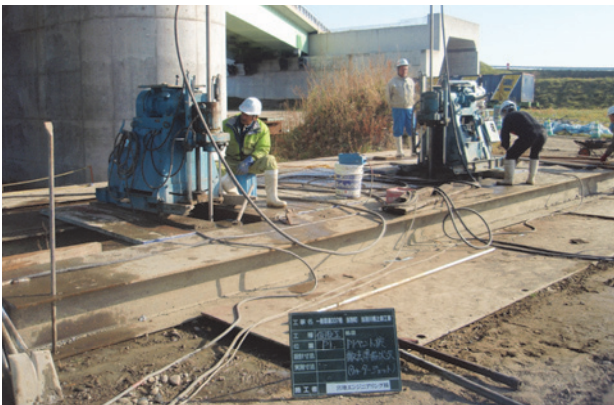
写真-11 ウォータージェット使用状況
