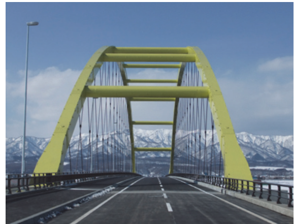
写真-1 完成全景 断面
