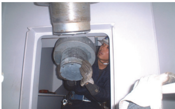
写真-7 ケーブル定着状況（補剛桁）
