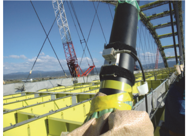
写真-10 ケーブル張力計測状況
