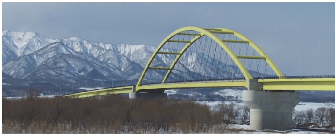
写真-2 完成全景
