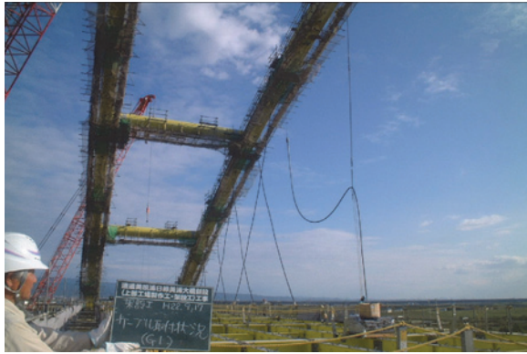
写真-6 ケーブル架設状況
