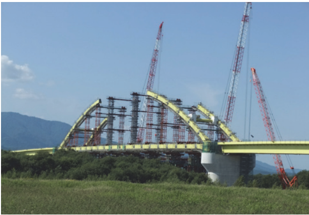
写真-5 アーチリブ架設状況
