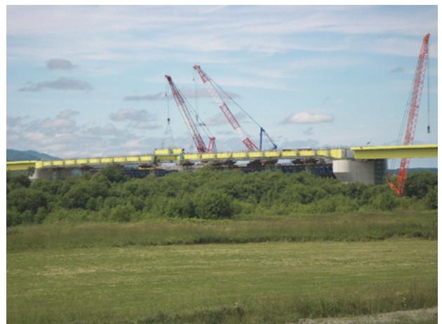
写真-4 補剛桁架設状況
