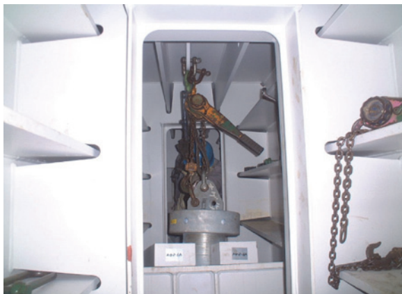
写真-8 ケーブル引き込み状況（アーチリブ）
