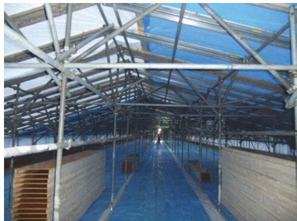
写真-11 床版寒中養生状況
