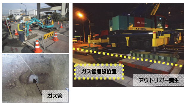
図一17 ガス管試掘・アウトリガー養生
