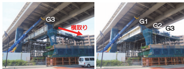
図一20 架設状況
