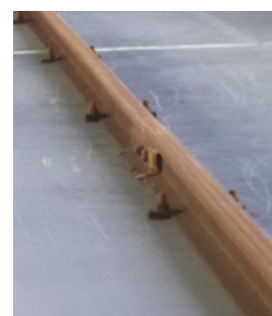
図-14 軌条設備固定用アンカー
