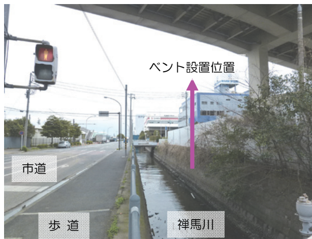
図-22 市道磯子301号と禪馬川 (施工前)
