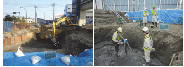
図-26 基礎掘削と地盤確認
