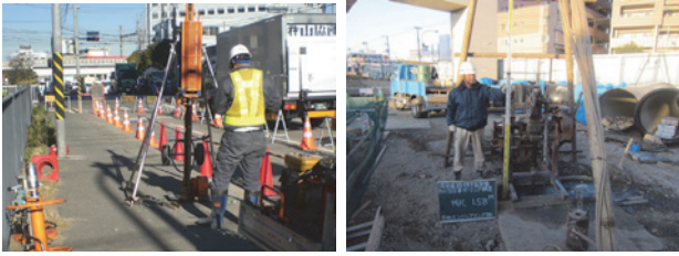
図-24 ボーリング調査
