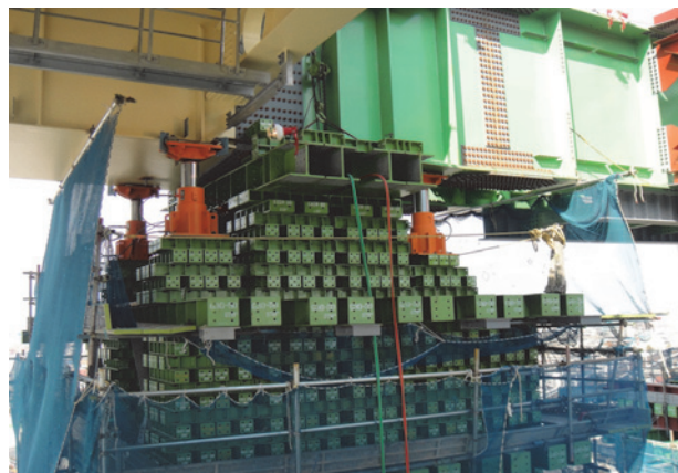
写真-4 桁降下状況
