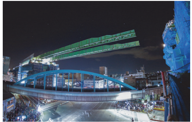
写真-1 第1回主桁送出し状況
