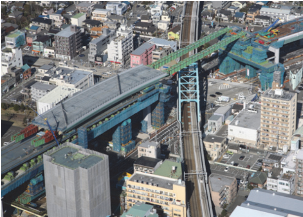
写真-2 第1回送出し完了
