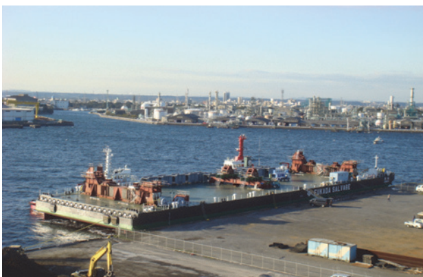
写真-2 輸送台船艤装状況
