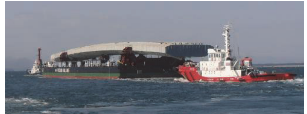
写真-1 No2ブロック台船輸送状況
