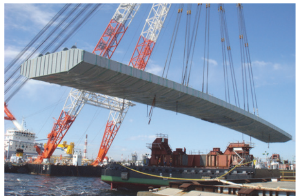
写真-3 大ブロックの積み込み状況
