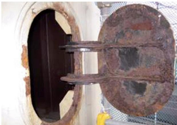
写真-9 錆付いた鋼製マンホールの事例
