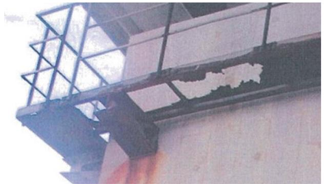
写真-2 歩廊が腐食して使用できない鋼製検査路
