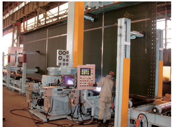
写真-2 自動組立溶接の状況
