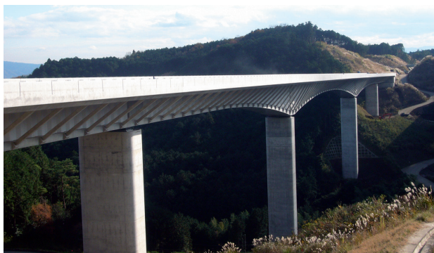
写真-2 (仮称)谷津川橋PC上部工(下り線)全景
