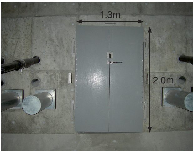
写真-5 (仮称) 谷津川橋 (下り線) 桁端扉および端支点検査孔蓋
