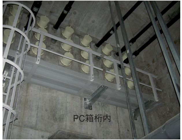
写真-3 (仮称) 谷津川橋 (下り線) 外ケーブル定着具検査路および梯子
