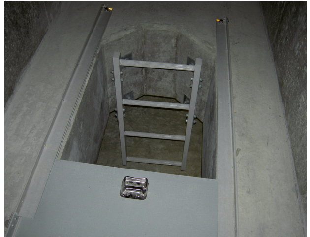
写真-4 (仮称) 谷津川橋 (下り線) 中間支点検査孔蓋および昇降梯子
