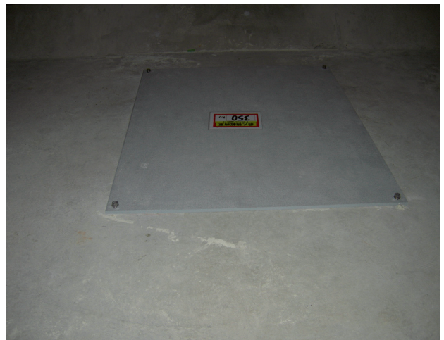
写真-5 (仮称) 谷津川橋 (下り線) 桁端扉および端支点検査孔蓋
