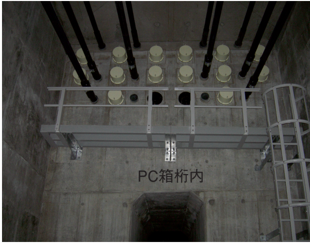
写真-3 (仮称) 谷津川橋 (下り線) 外ケーブル定着具検査路および梯子
