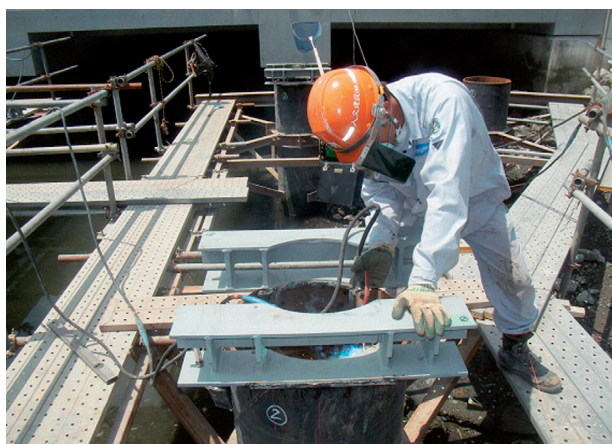
写真-3 受梁設置状況
