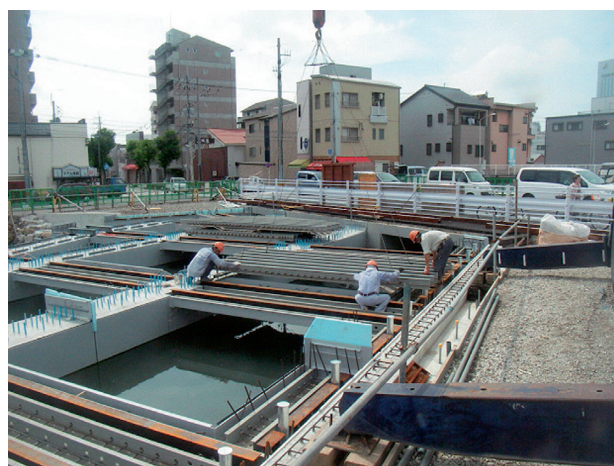
写真-6 床版パネル架設状況
