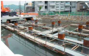
写真-1 足場設置状況
