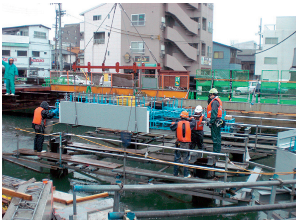
写真-5 主桁パネル架設状況
