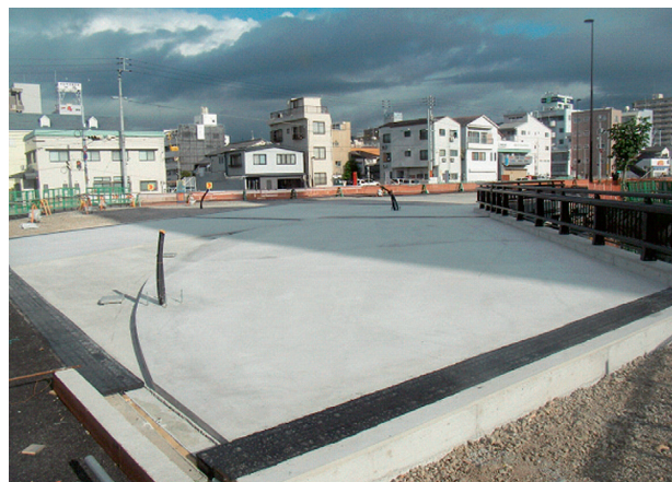
写真-10 完成状況
