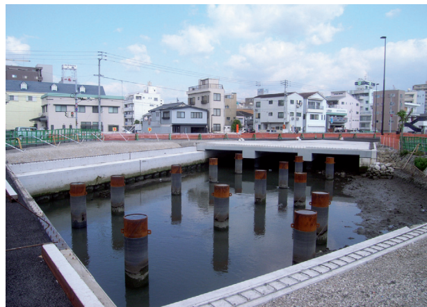
写真-9 施工前状況
