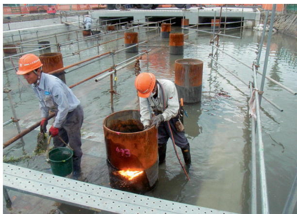
写真-2 鋼管杭ガス切断状況
