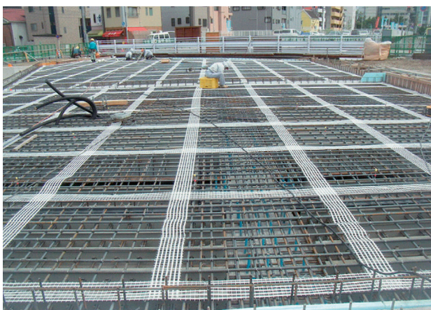
写真-7 ひび割れ抑制ネット敷設状況
