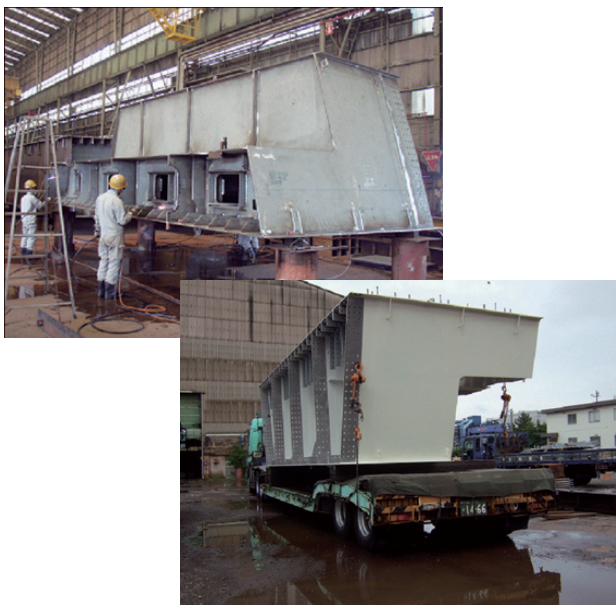
写真-12 取替桁製作・運搬状況
