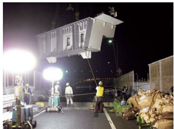
写真一18 新設桁設置状況
