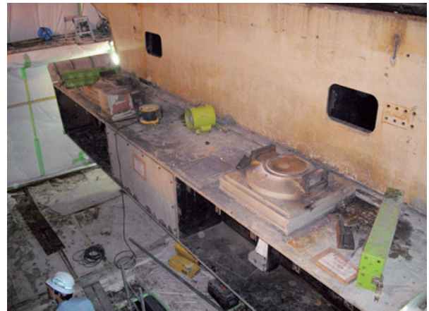
写真一17 既設橋脚状況
