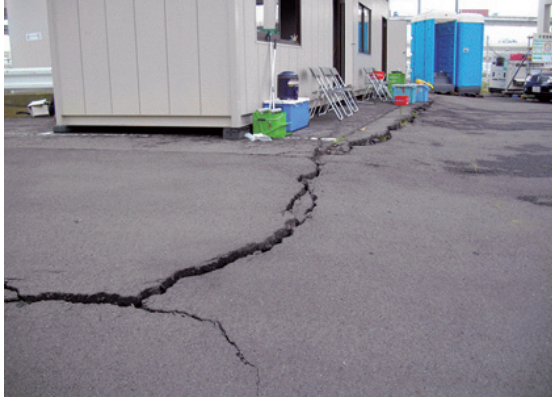
写真-1 橋脚周辺地盤の液状化
