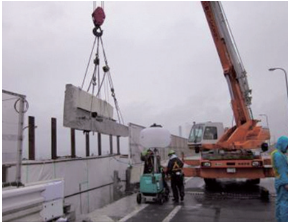
写真一14 壁高欄撤去状況
