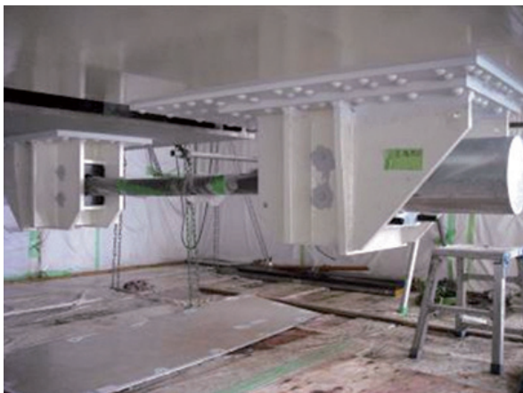
写真-23 落橋防止装置設置状況
