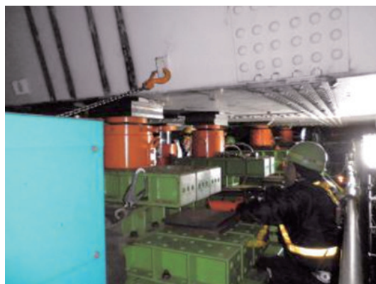
写真-9 ジャッキアップ状況
