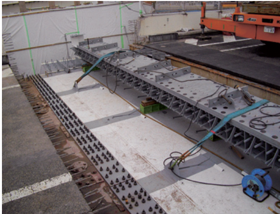
写真-19 伸縮装置搬入状況
