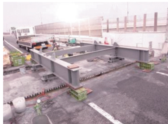
写真-13 セッティングビーム設置状況
