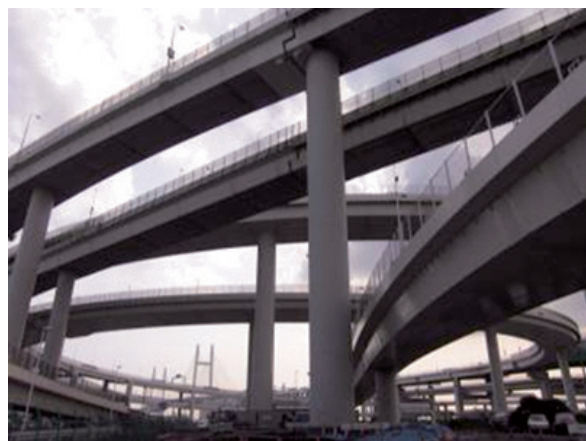
写真-25 大206災害復旧完了状況（桁下）
