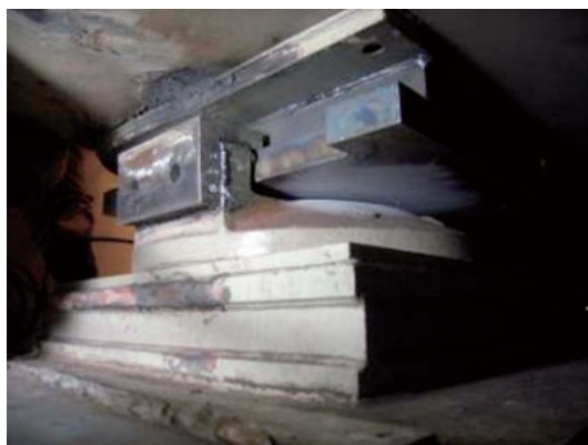
写真-10 仮上沓設置状況
