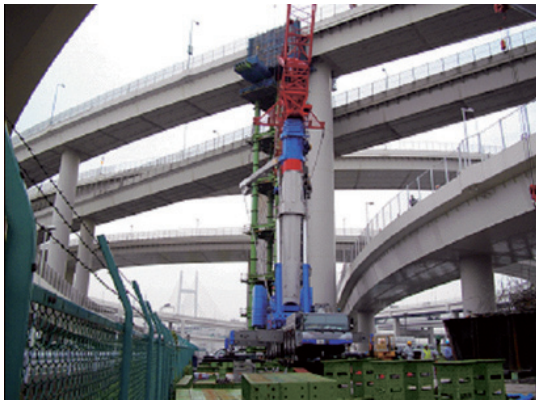
写真一14 壁高欄撤去状況
