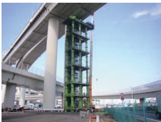
写真-8 ベント設置状況
