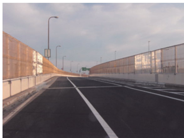
写真-26 大206災害復旧完了状況（橋面）
