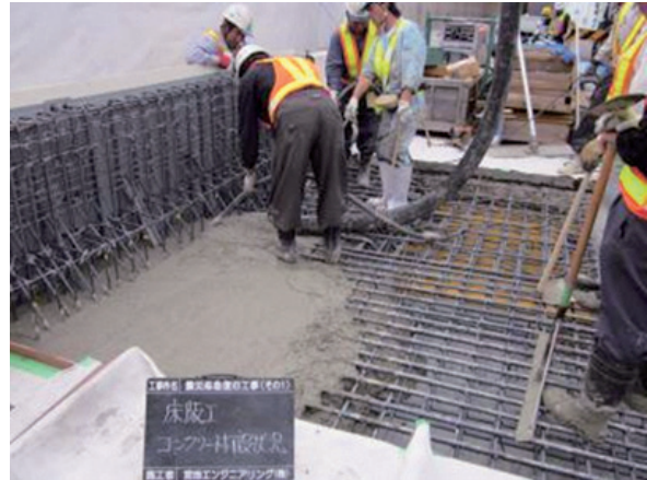
写真-20 コンクリート打設状況
