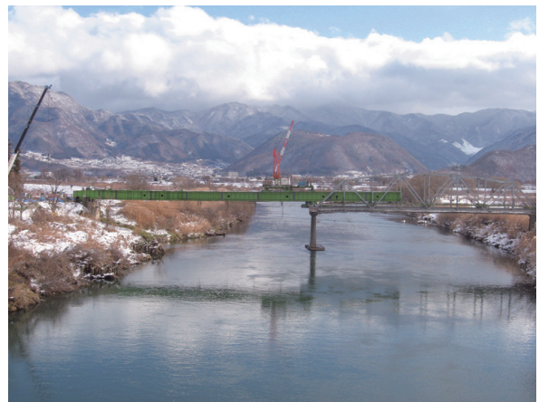
写真-12 撤去状況
