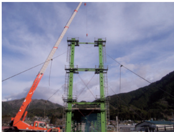
写真-2 鉄塔組立状況
