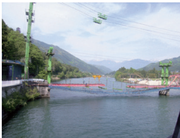
写真-4 撤去状況
