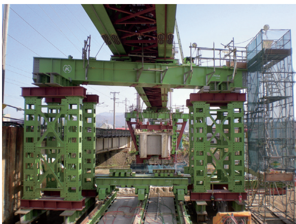
写真-19 撤去状況
