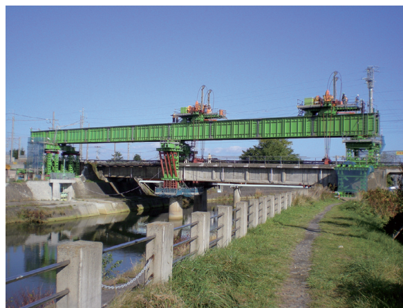
写真-18 撤去状況
