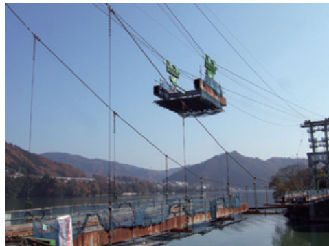
写真-6 撤去状況
