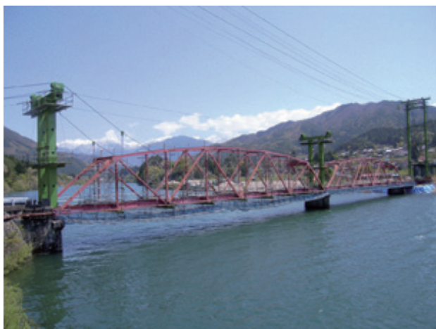
写真-3 撤去状況
