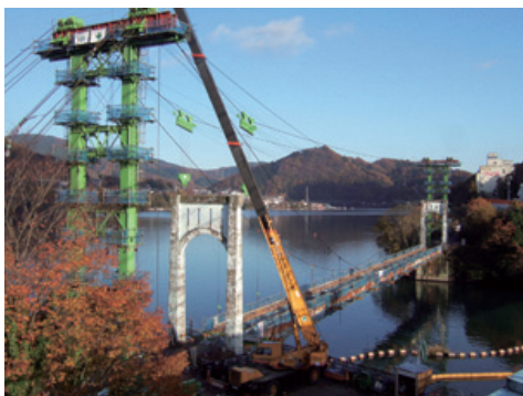
写真-7 撤去状況
