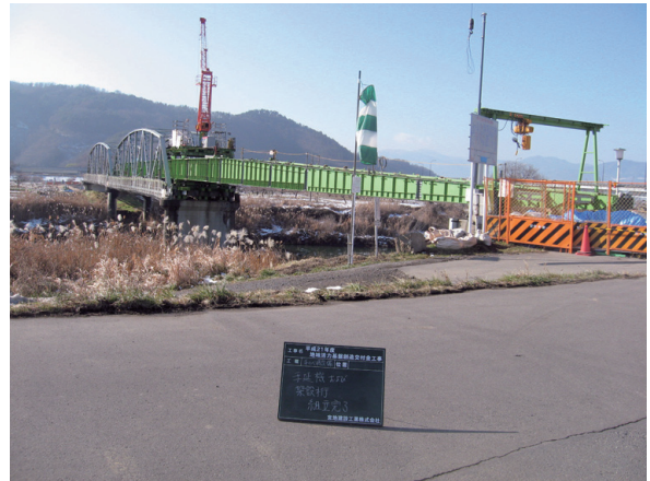
写真-10 撤去状況
