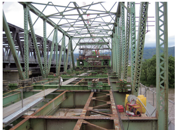
写真-16 撤去状況
