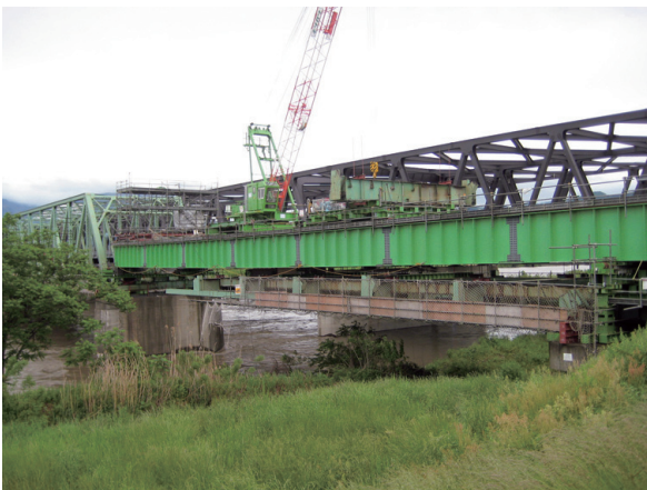
写真-15 撤去状況
