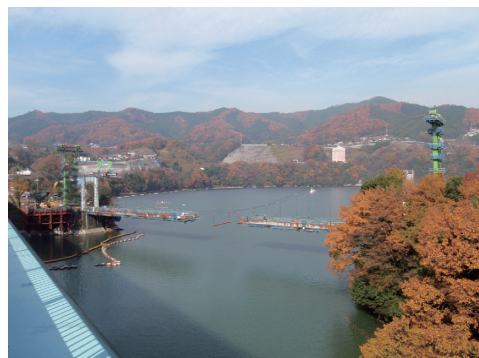
写真-8 撤去状況
