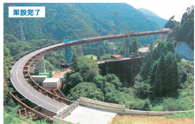
写真-1 現地架設完了状況
