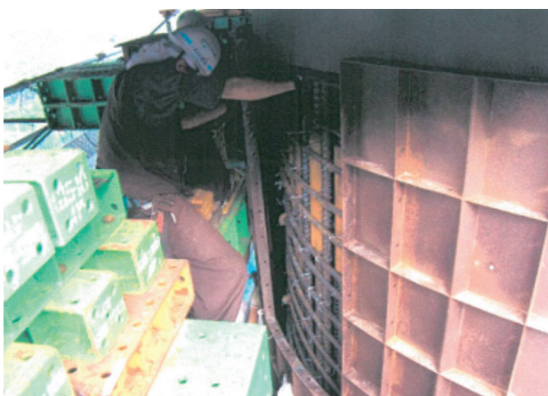
写真-5 鋼製型枠の設置
