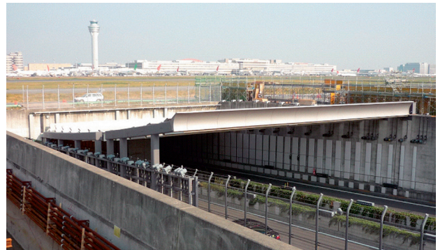
写真-2 遮光ルーバー
