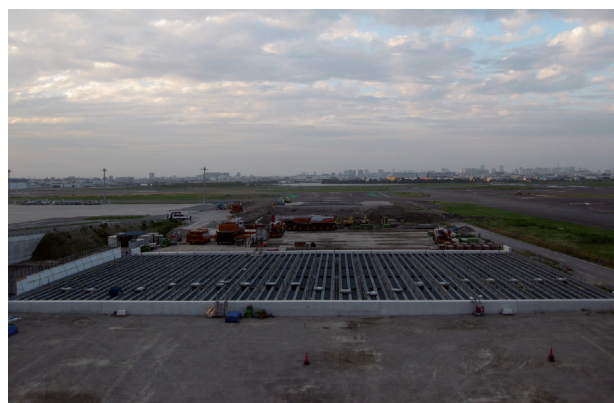
写真-9 全22ブロック架設完了
