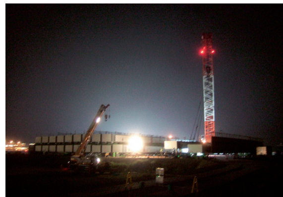
写真-7 夜間の桁移動
