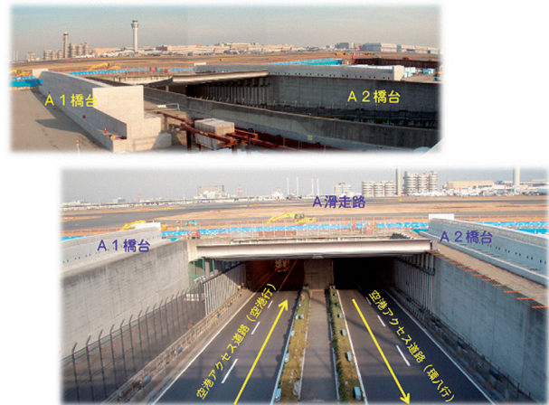
写真-1 現場状況写真
