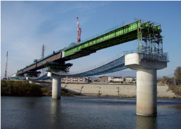
写真-1 架設状況
