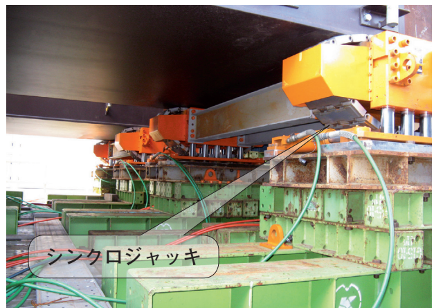
写真-7 高架橋上送り出し設備
