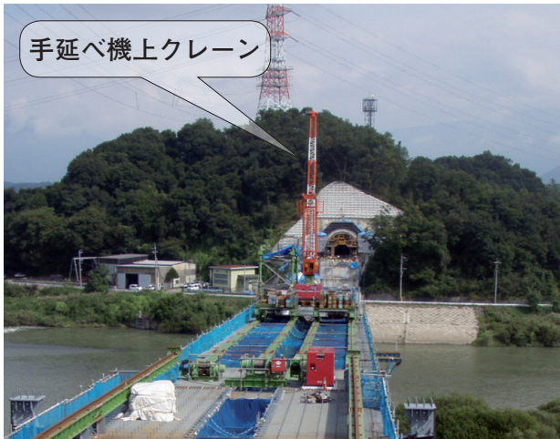
写真-8 手延べ機上クレーン設置状況
