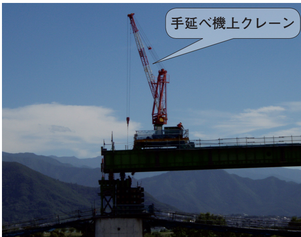
写真-9 手延べ機上クレーン作業状況
