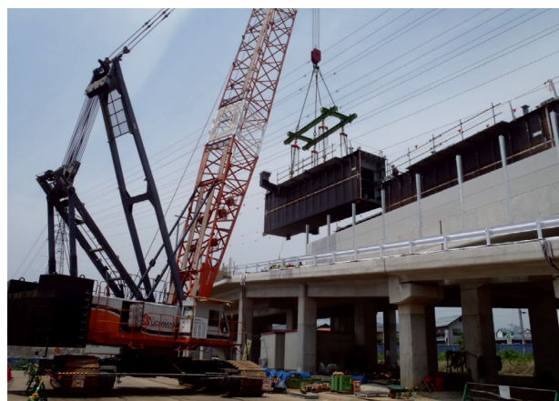
写真-3 高架橋上桁組み立て状況
