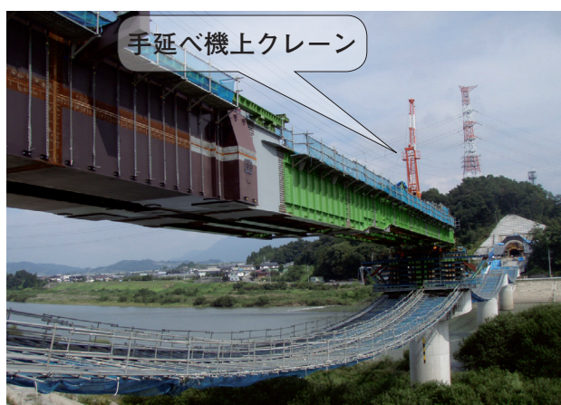
写真-4 手延べ機取り付け状況
