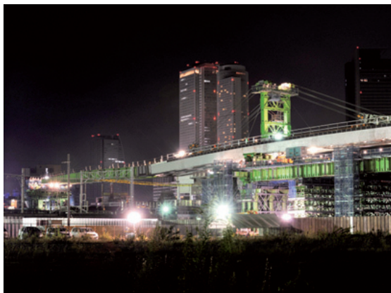
写真-5 送出し状況
