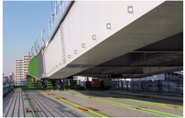
写真-4 手延べ機先端のジャッキダウン状況
