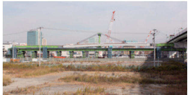
写真-1 送出し時全景
