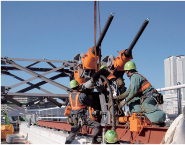
写真-2 引き込み設備組立状況
