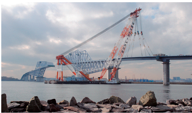
写真-11 架設状況写真
