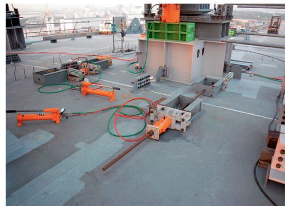
写真-4 仕口調整設備 (DECK)
