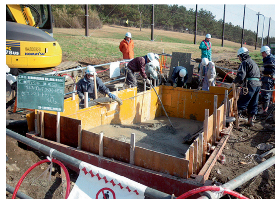
写真-5 陸上アンカー施工状況
