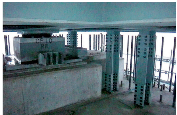
写真-13 橋脚部仮固定設備
