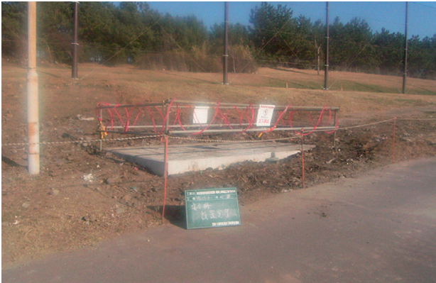
写真-6 陸上アンカー
