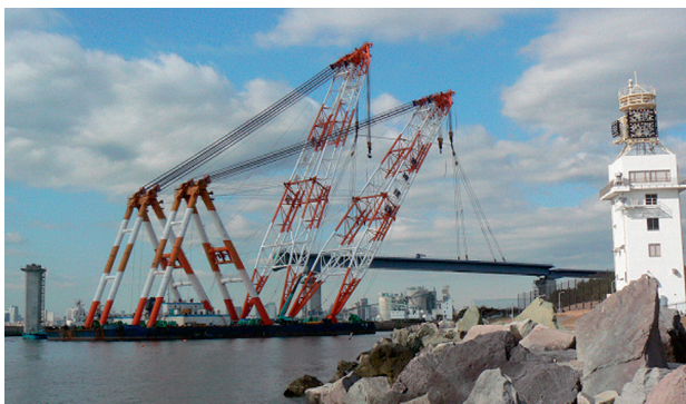
写真-12 架設状況写真
