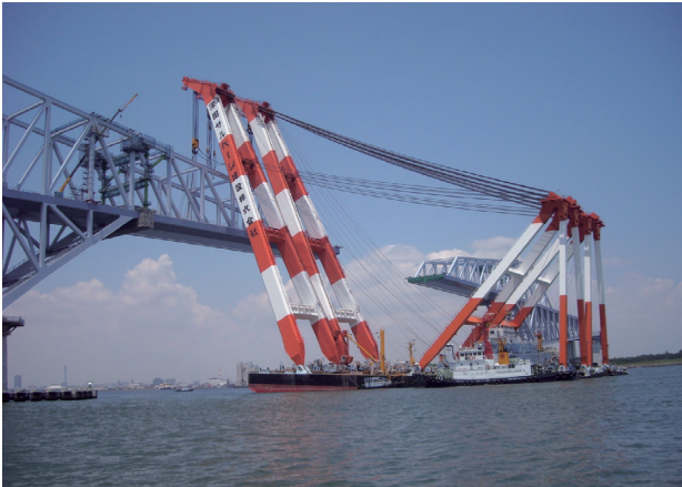
写真-4 中央径間トラス架設状況（中防側）
