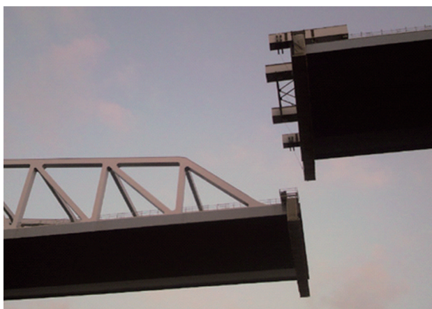
写真-9 大ブロックジョイント部
