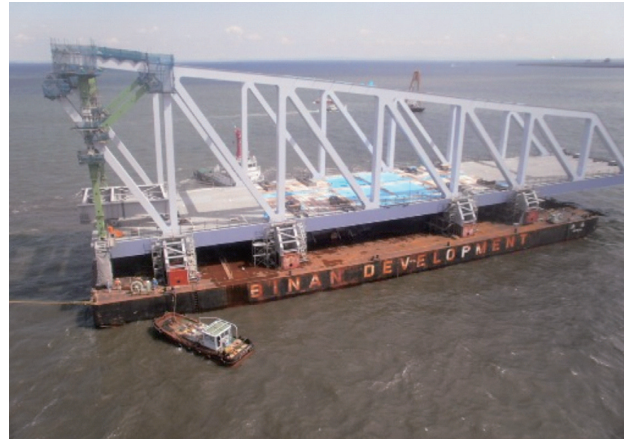
写真一3 作業区域へ入域する中央径間トラス（中防側）
