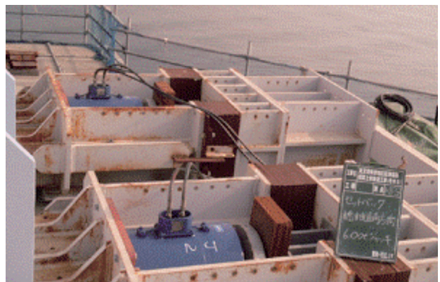
写真－7 セットバック（橋軸方向）
