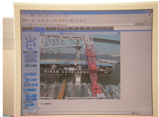
写真-6 カメラでの監視システム
