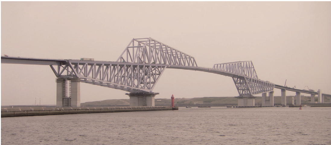
写真-12 東京ゲートブリッジ全景
