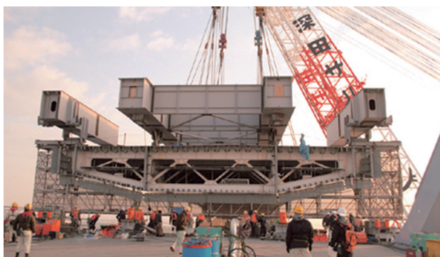
写真-8 中央径間箱桁の架設
