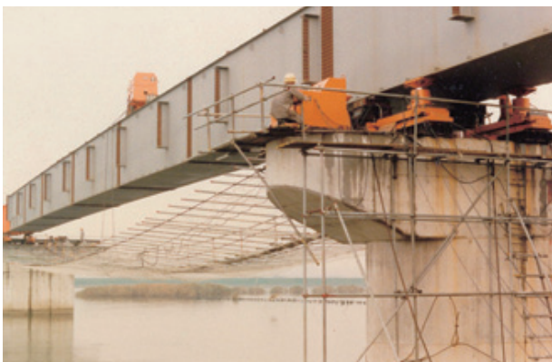
写真-13 BC291工区の送り出し架設
