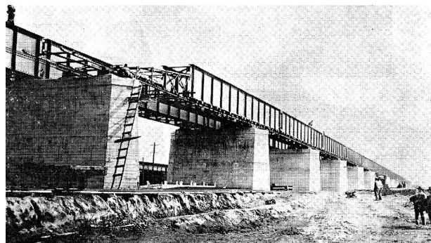
写真-6 ガーダーの連結式架設（1） （東北本線・荒川橋梁、昭和2年）
