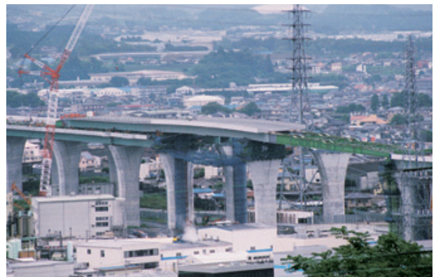
写真-16 身延線第二東名Bo上部工新設送り出し架設工事
