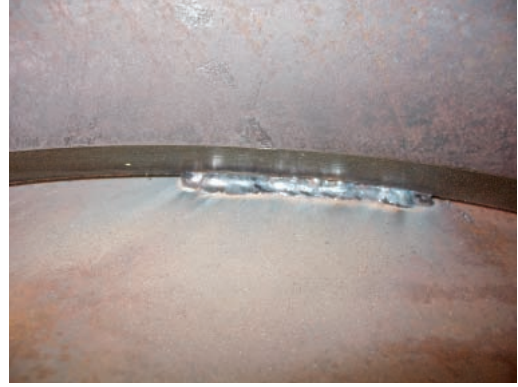
写真-7 組立溶接 (ルート間隔 1.5mm)
