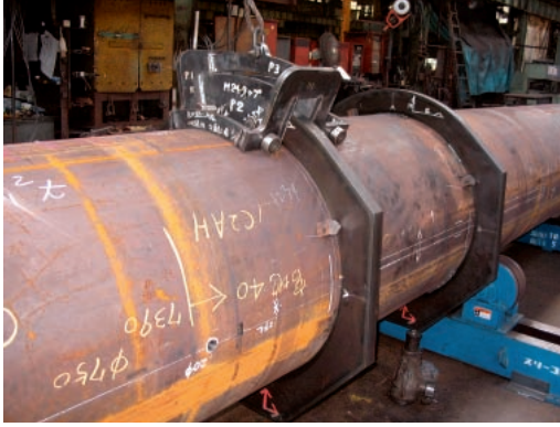
写真-4 外リング挿入
