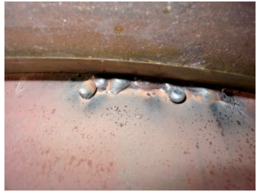
写真-8 組立溶接 (ルート間隔 3.5mm)
