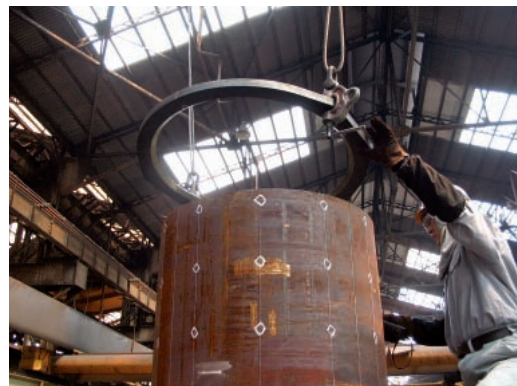
写真-3 外リング挿入
