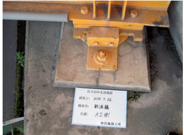
写真二 支承の例
